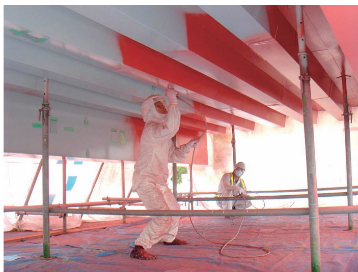
写真-4 予備試験状況
