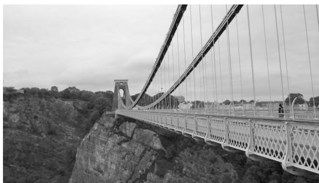
写真-1 クリフトン吊橋(L=192m、1864年完成)
