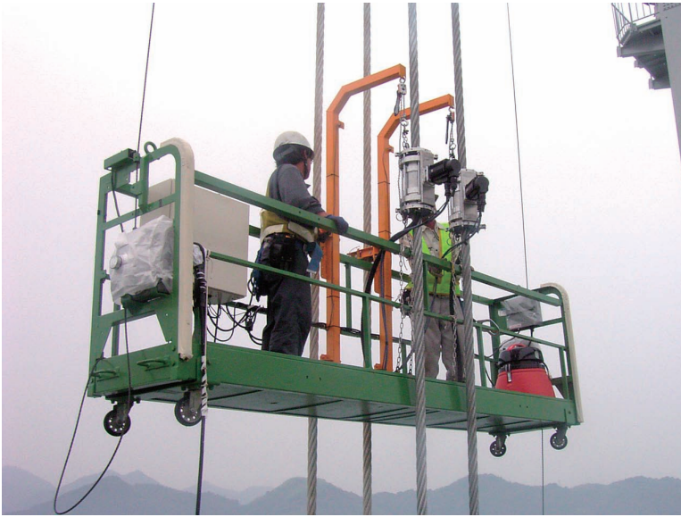
写真-5 素地調整装置全体 Surface treatment machine device
