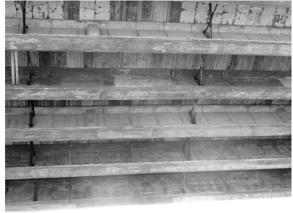
写真-19 プレキャスト床版状況 Photo 19 Precast Concrete Deck
