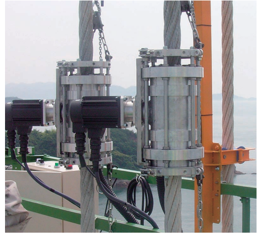
写真-6 素地調整装置本体 Surface treatment machine for ropes
