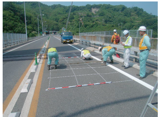
写真-2 ブリスタリング調査状況
