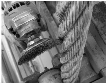
写真-1 素地調整作業状況 Photo 1 Surface treatment works
