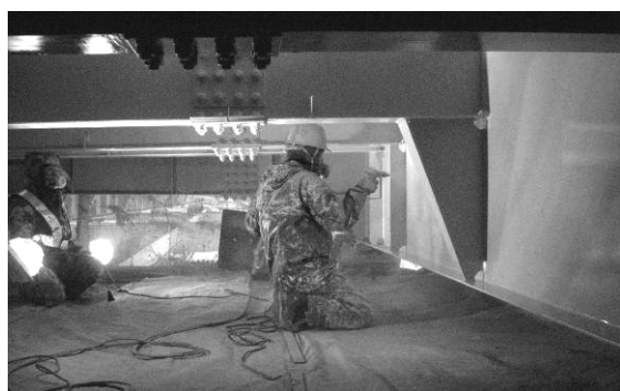
写真-1 スプレー塗装作業状況 Photo 1 Work situation of sprayed coat
