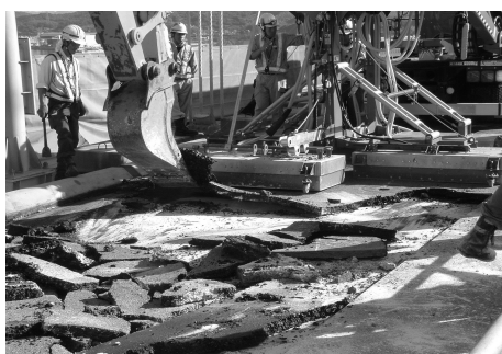
写真-3 IH工法による舗装の剥ぎ取り Photo3 Removal of pavement with IH method
