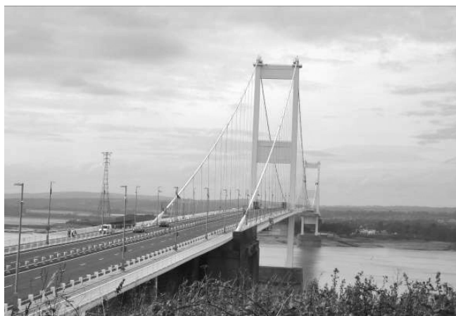
写真-2 セバーン橋(L=988m、1966年完成)
