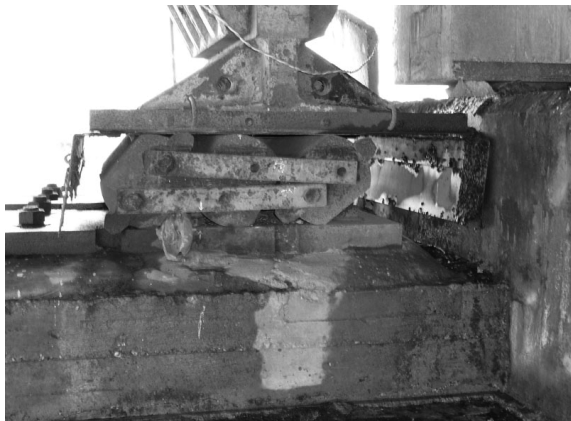
写真-9 トラス部の支承（ロッカーシュー） Photo 9 Rocker bearing of Truss Bridge
