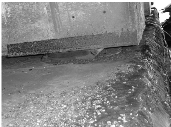
写真-10 取付高架橋の支承（ゴム製） Photo 10 Rubber Bearing of Approach Viaduct
