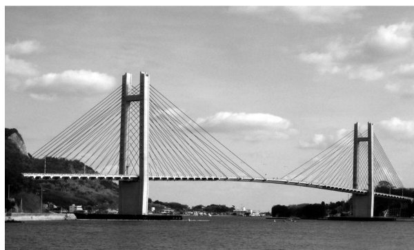
写真-2 生名橋全体写真
