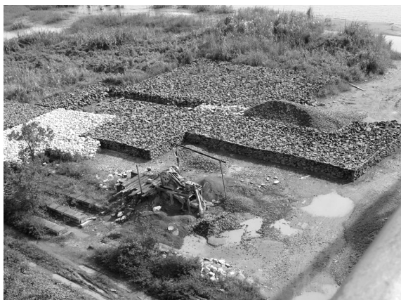
写真-11 石のストックヤード Photo 11 Stone Stockyard
