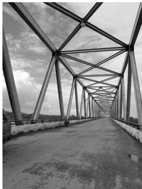
写真-8 Maubin 橋 Photo 8 Maubin Bridge
