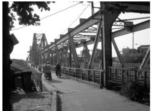
写真-4 ロンビエン橋
