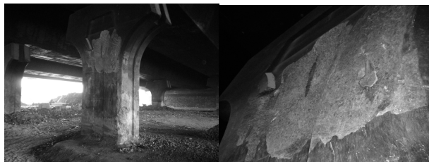
写真-3 橋脚の管理状態 Photo 3 Maintenance Condition of Bridge Pier
