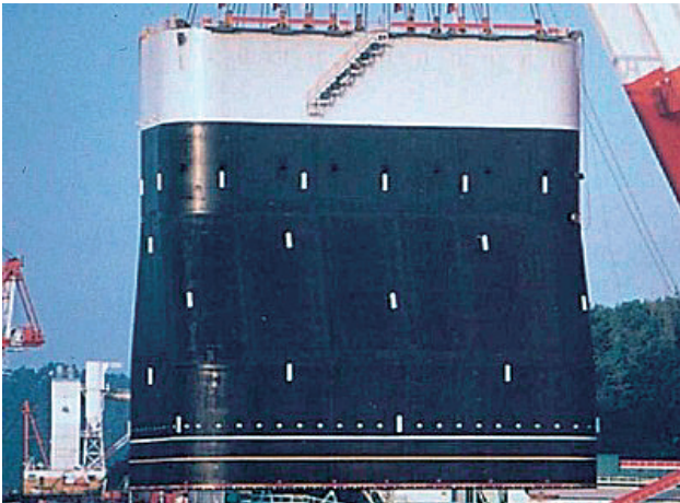
写真-3 3P 鋼製ケーソン 3P steel caisson
