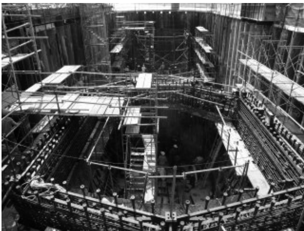
写真-11 主塔工事 (P13)
