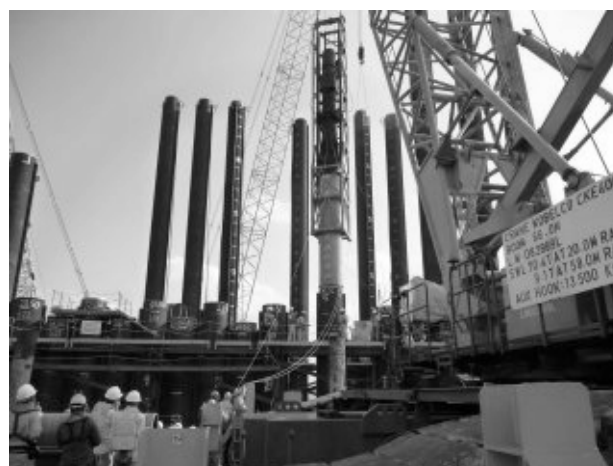
写真-8 鋼管杭打設（ディーゼルハンマー、P15） Photo 8 Casting Steel Pile (Diesel Hammer, P15)
