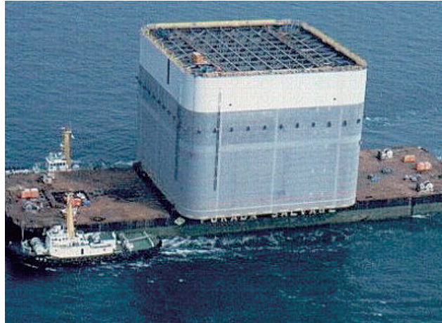
写真-4 4A 鋼製ケーソン 4A steel caisson
