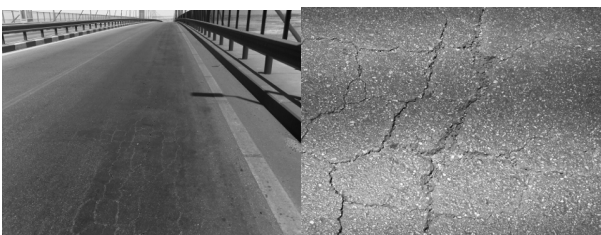
写真-6 スエズ運河架橋の橋面舗装
