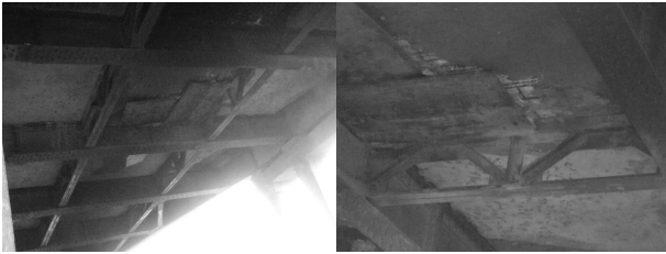
写真-4 床版の管理状態
