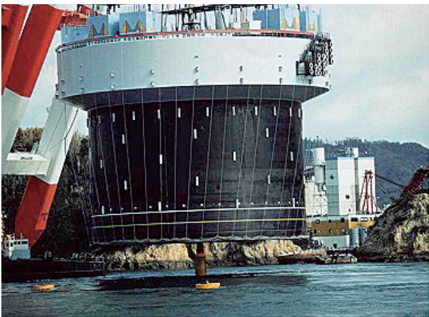
写真-5 5P 鋼製ケーソン 5P steel caisson
