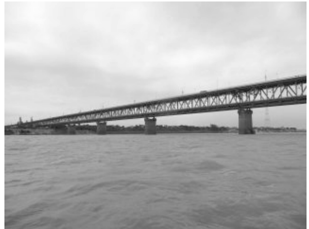
写真-3 タンロン橋
