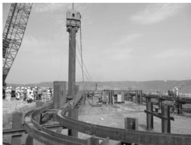
写真-7 導枠と試験杭 (P14) Photo 7 Guide Pile and Test Pile (P14)
