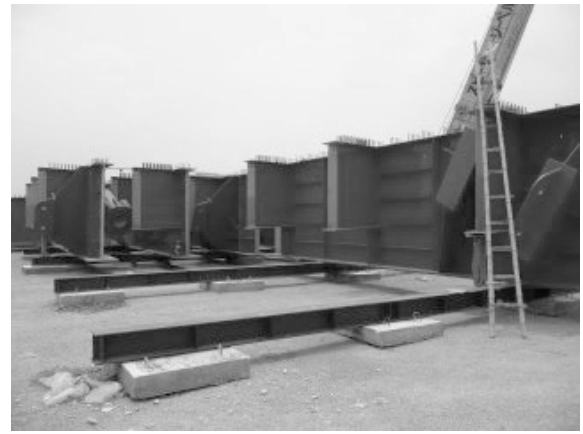
写真-13 主構の現地仮置
