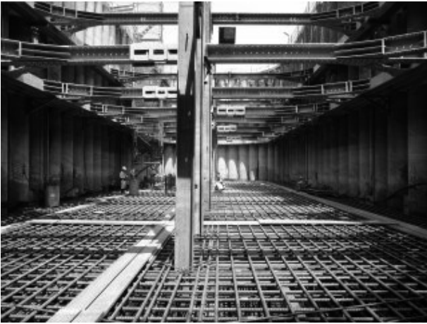
写真-10 頂版鉄筋工 (P12)
