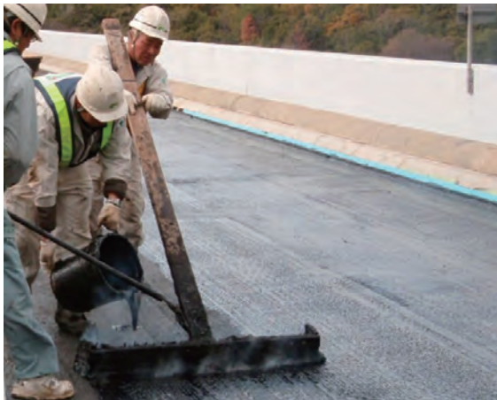
写真-2 塗膜防水工（路面全体）
