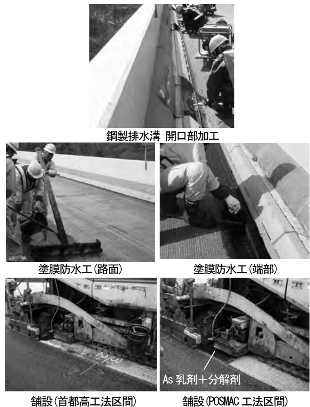
写真-4 試験舗装状況
