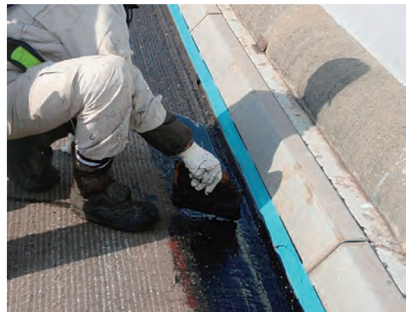
写真-3 塗膜防水工（路面端部）
