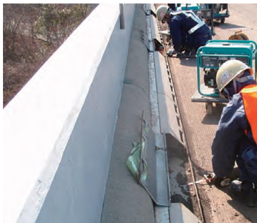
写真-4 鋼製排水溝 開口部加工
