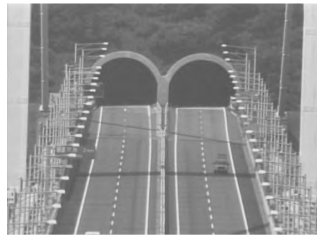
写真-4 SB3Pより北向き望遠時（既設カメラ）
