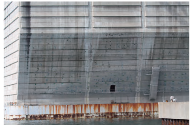
写真-6 事前調査状況 (BB7AOH部)
