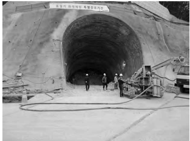
写真-1 トンネル式アンカレイジ施工状況
