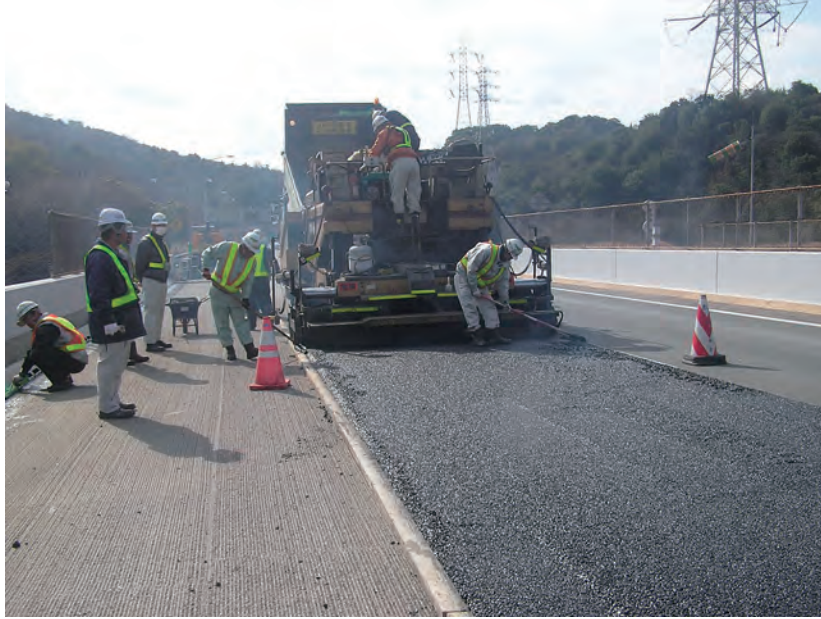
写真-1 舗設状況
