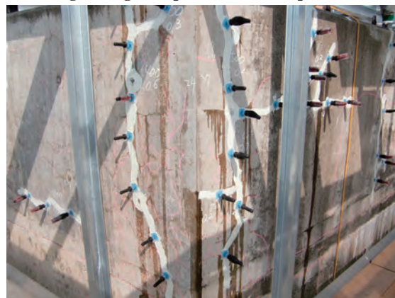
写真-5 エポキシ樹脂の注入 Photo 5 Injection of epoxy resin
