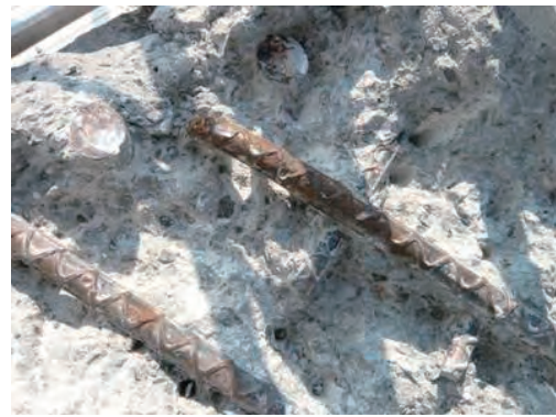
写真-2 内部鉄筋状況 (HVa21P天端面)
