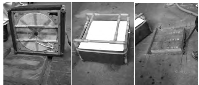
[加熱機器] [加熱状況] [舗装剥ぎ取り]
