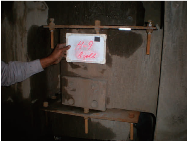
写真-6. ヒンジ部の応急補修
