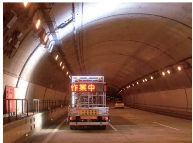
写真-2 ハイビジョンカメラ計測車両による計測状況
