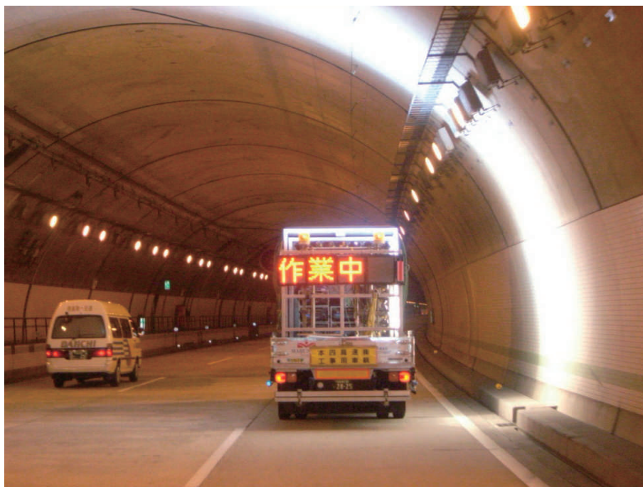
写真-2 ハイビジョンカメラ計測車両による計測状況 Tunnel inspection by using high-vision camera
