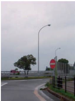
写真-1 照明柱全景
