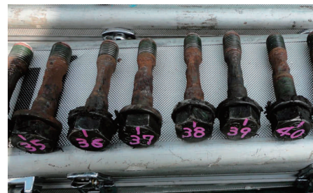
写真-4 セットボルトの断面欠損状況(1)
