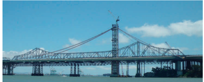
写真-2 建設中の自碇式吊橋
