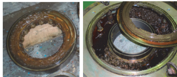
写真-9 主電動機軸受とベアリングカバー
