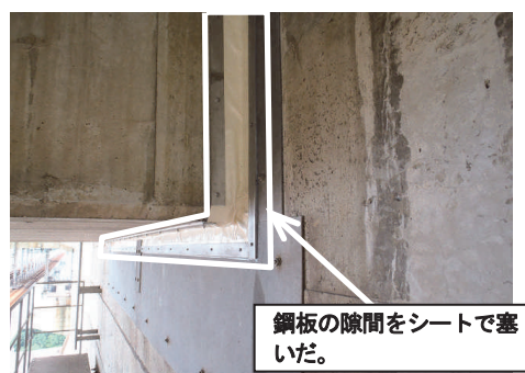
写真-4 SB4A東気密対策実施状況
