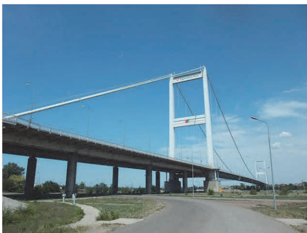
写真-1 イルティッシュ川橋梁全景 Photo 1 Overview of Irtysh River Bridge
