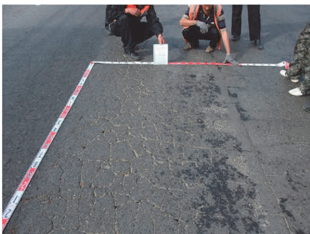
写真-3 舗装近景（中央径間部） Photo 3 Closeup View of Pavement (Center Span)
