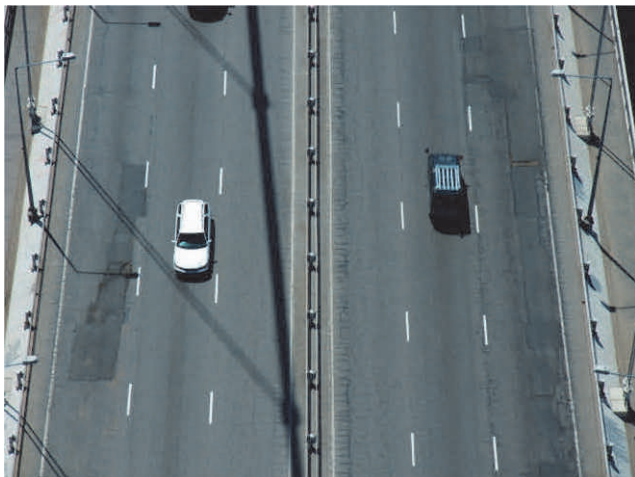
写真-2 舗装近景（中央径間部） Photo 2 Overview of Pavement (Center Span)
