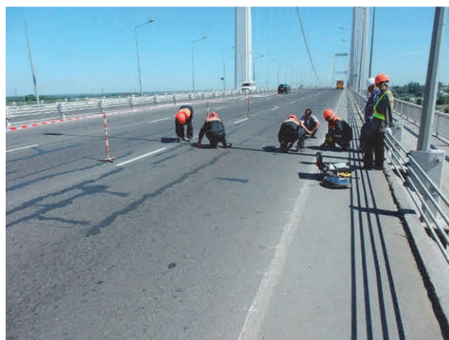
写真-5 舗装全景（側径間部） Photo 5 Overview of Pavement (Side Span)
