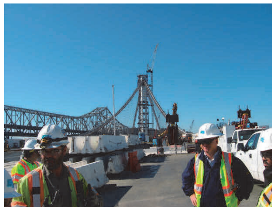
写真-3 建設中の自碇式吊橋
