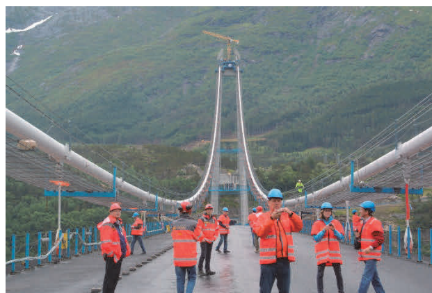
写真-2 路面から見た主塔の様子(ハルダンゲル橋)
