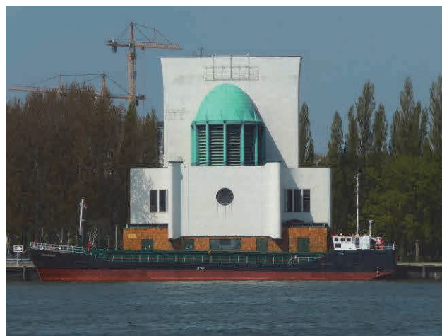
写真-2 マーストンネル換気所兼自転車歩行者の入口
