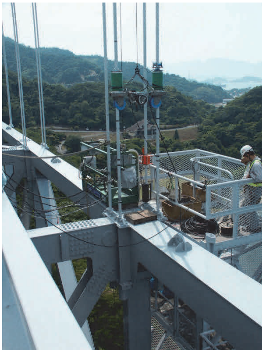
写真-3 因島大橋 ハンガーロープ一般部 連続測定 Continuous measurement for general part of suspender ropes of Innoshima Bridge
