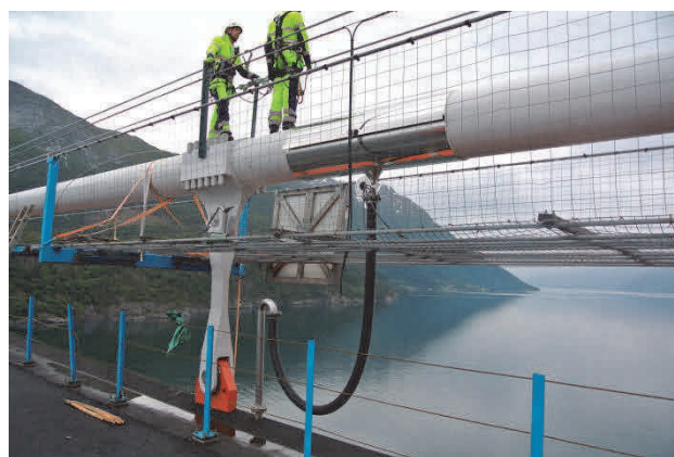
写真-3 ケーブル送気乾燥システム(送気バンド)
