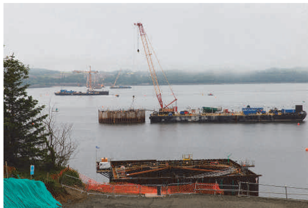
写真-4 第二フォース道路橋の建設状況 (2016年完成予定)
