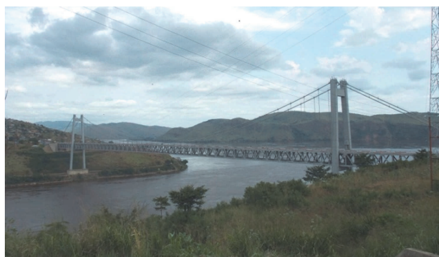
写真-1 マタディ橋全景
