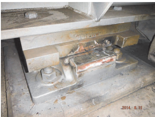
写真-10 サイドブロック・下沓突起の撤去 Photo 10 Removal of side block and stopper of bearing
