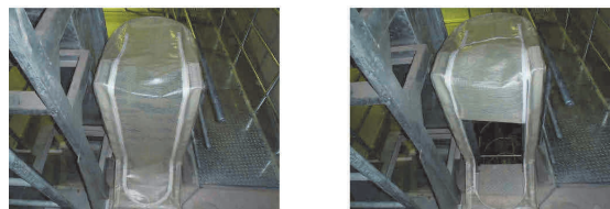
写真-3 タラップ部の防湿シート配置
