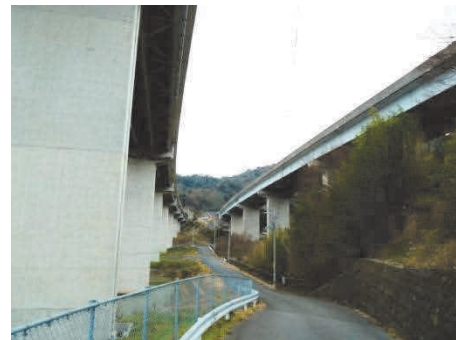
写真-1 橋脚と周辺道路
