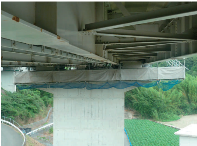
写真-6 橋脚天端周囲に設けた足場
