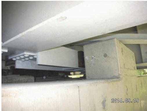
写真-14 RC突起+鋼製横梁
