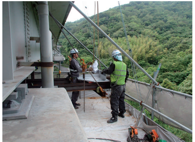
写真-7 本線からの部材搬入
