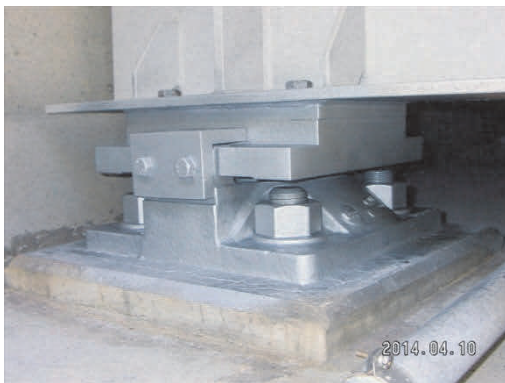
写真-15 亜鉛アルミ溶射による支承防せい
