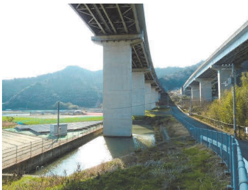
写真-3 ため池の中の橋脚 Photo 3 A pier in a pond
