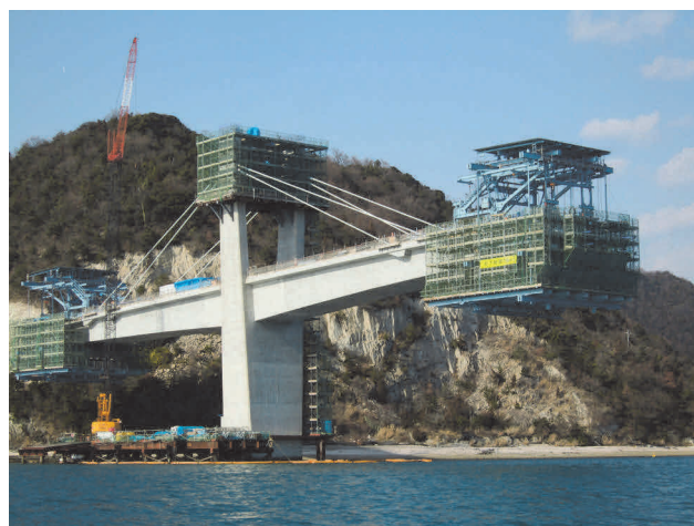
写真-2 超大型移動作業車による張出架設
