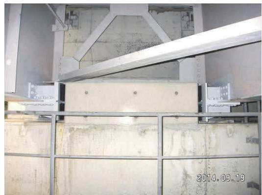
写真-13 RC突起+鋼製ブラケットの設置 Photo 13 RC shear key and steel bracket
