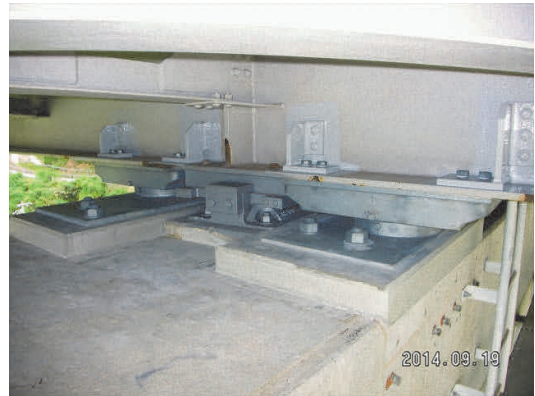
写真-11 せん断ストッパーの設置 Photo 11 Shear stopper
