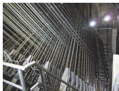
写真-1 BB4A スプレー室内のストランド配置 Photo.1 Arrangement of cable strands inside splay chamber (BB4A)
