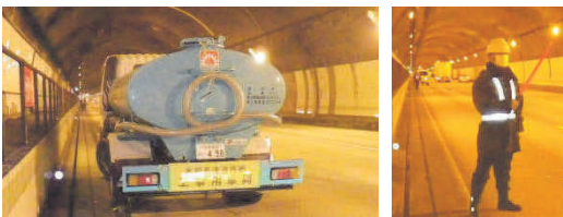
写真-9 散水車の配置と監視員
