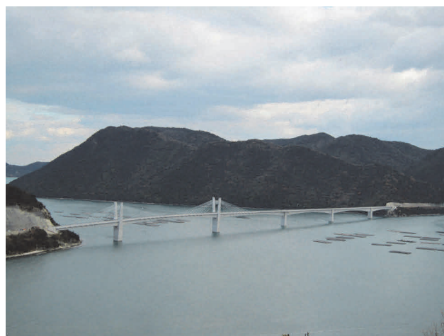
写真-1 備前♡日生大橋全景
