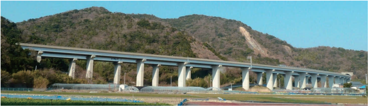
写真-5 土佐泊浦高架橋全景
