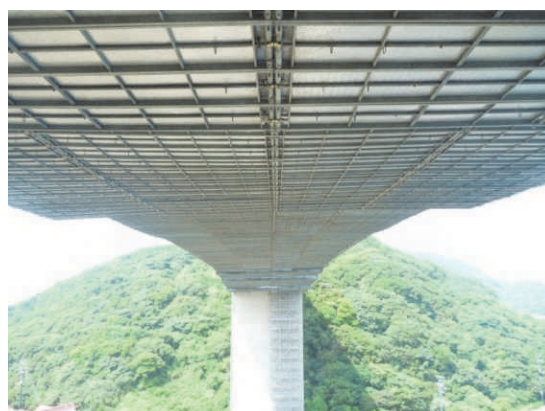
写真—6 固定吊足場（下面）
