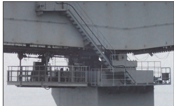
写真-2 門崎高架橋上部作業車と下部作業車
