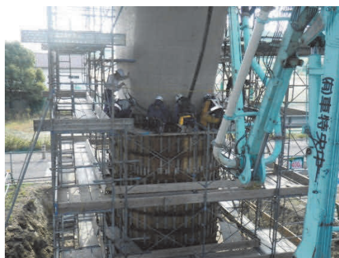
写真-4 コンクリート打設状況 Photo 4 Concrete placement
