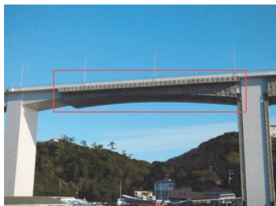
写真—4 固定吊足場（全景）
