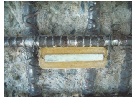
写真-11 ガルバシールド設置状況
