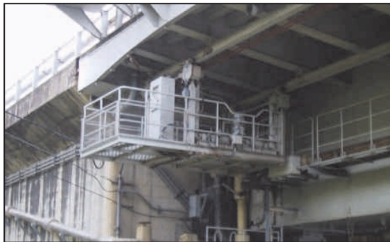
写真-2 門崎高架橋上部作業車と下部作業車
