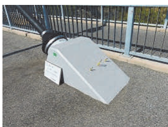
写真-1 ケーブル保護コンクリート
