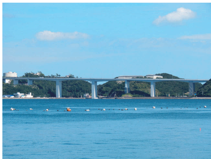
写真-6 亀浦高架橋全景-2
