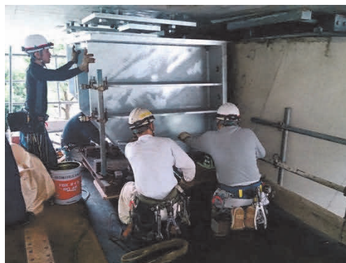
写真-9 鋼製ブラケットの設置
