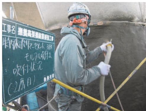
写真-5 モルタル吹付状況 Photo 5 Mortar blowing
