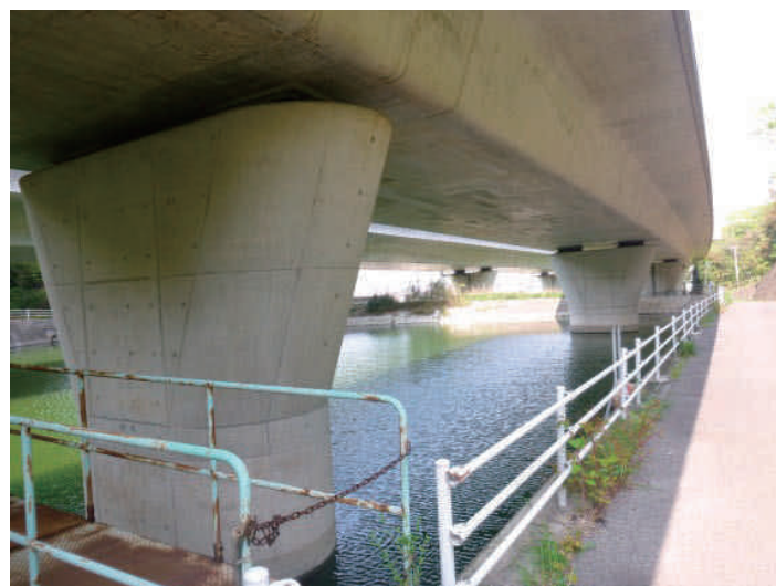
写真-3 ため池の中の橋脚
