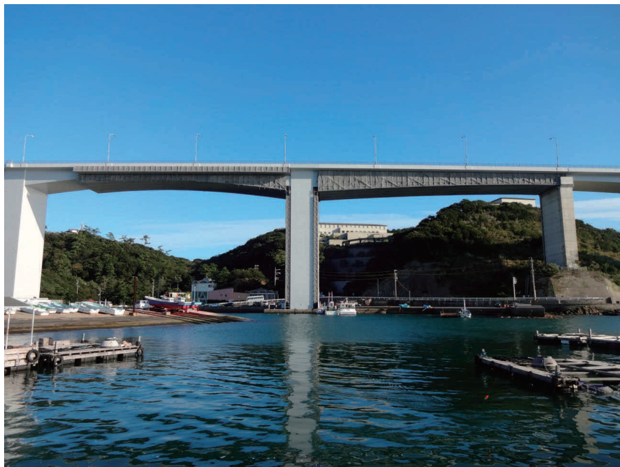
写真-4 亀浦高架橋固定吊足場設置状況(4P-6P 上部工)
