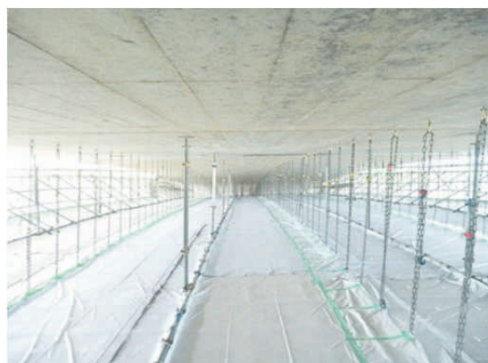
写真—5 固定吊足場（内部）
