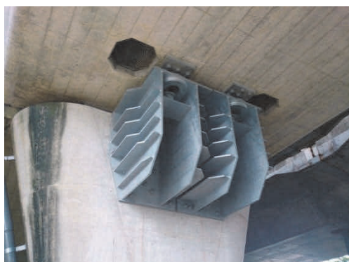
写真-7 変位制限構造設置状況
