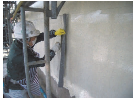
写真-12 剥落対策シート貼付け状況
