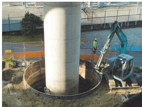
写真-3 特殊部掘削状況 Photo 3 Earthwork
