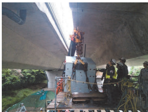
写真-8 ローラー台車への仮置き
