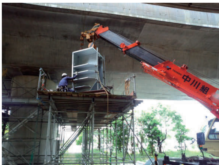
写真-2 鋼製架台と部材取り込み
