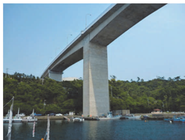
写真-1 亀浦高架橋
