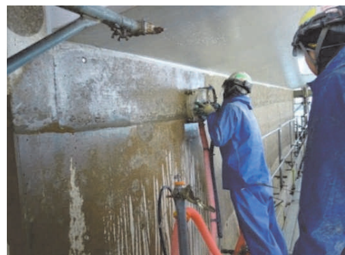
写真-8 WJによる下地処理
