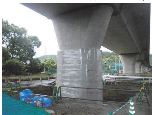
写真-6 コンクリート養生状況
