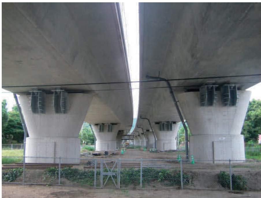
写真-1 工事完成状況
