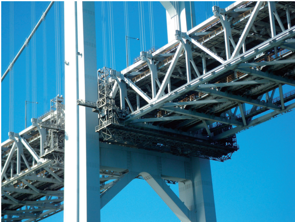
写真-2 南備讃瀬戸大橋桁外面作業車
