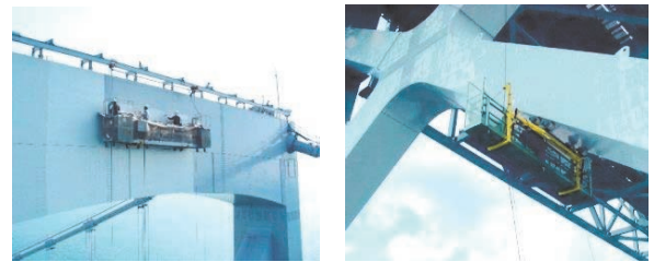
写真-8 磁石車輪ゴンドラによる補修塗装
