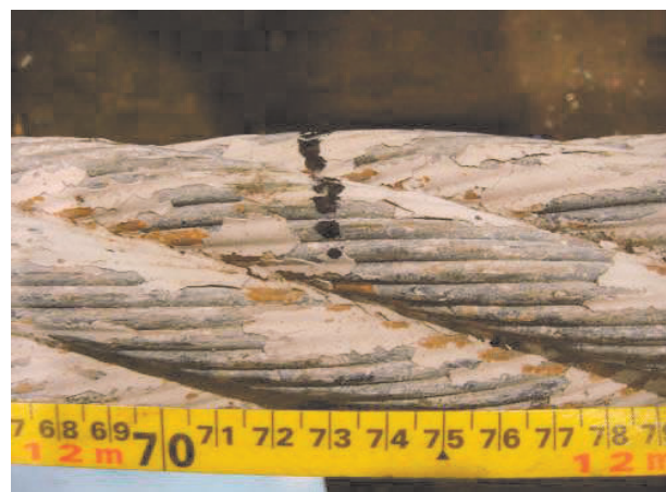
写真-5 一般部 (定着部から12.73m地点)
