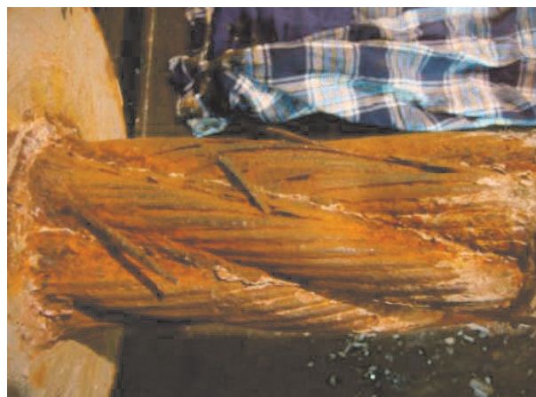
写真-4 定着部近傍部 (定着部から0~150mm付近)
