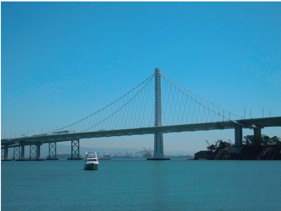
写真-9 サンフランシスコ・オークランドベイ橋 (自碇式吊橋)
