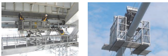
写真-2 桁内面作業車（左）とケーブル作業車（右）
