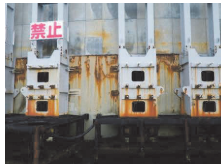
写真-4 主塔海上部状況 Photo 4 Scattering zone
