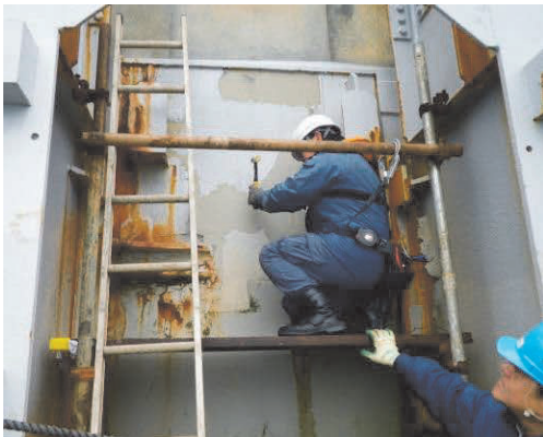
写真-2 打音点検状況 Photo 2 Hammering inspection
