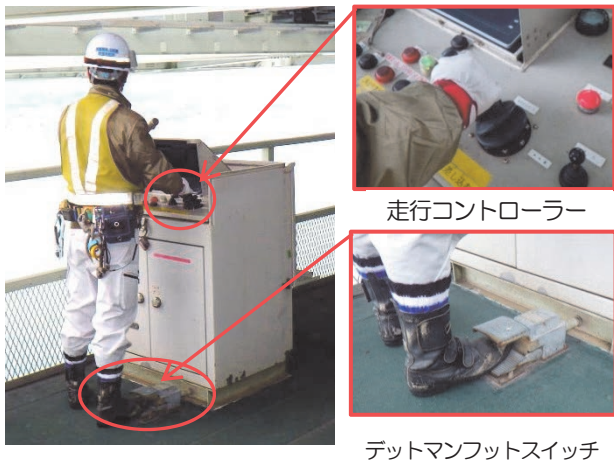
写真-9 デッドマンスイッチを採用した操作盤 Photo 9 Control panel with deadman switch
