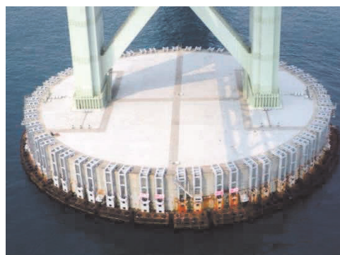
写真-1 2P 主塔基礎全景
