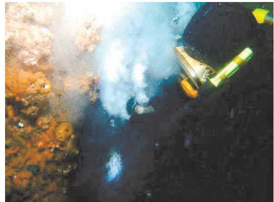
写真-3 海洋性付着物除去状況 Photo 3 Removing marine organism
