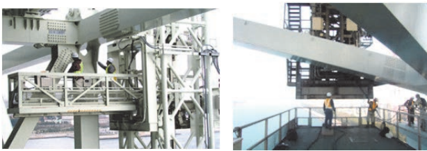
写真-3 伸縮足場 Photo3 Extension platform 写真-4 下面作業台切離し Photo4 Disconnected platform
