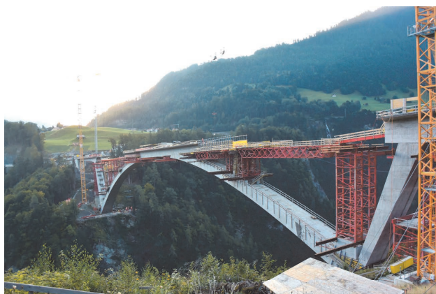
写真-2 テクニカルビジット (Tamina Bridge) (長大橋技術センター防食・耐風グループ 楠原栄樹)
