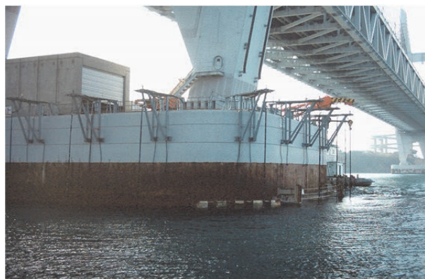
写真-1 電着防食の施工状況
