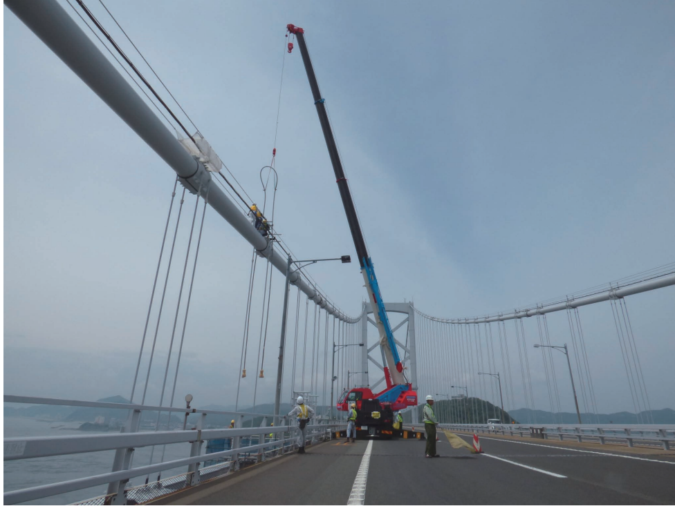
写真-5 大鳴門橋ハンガーロープの架替え作業
