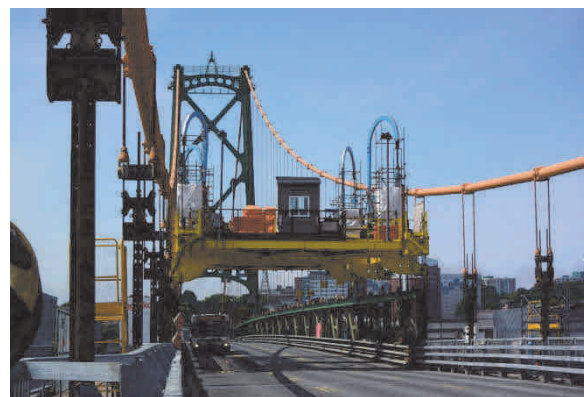
写真-3 架替え工事中の Macdonald Bridge
