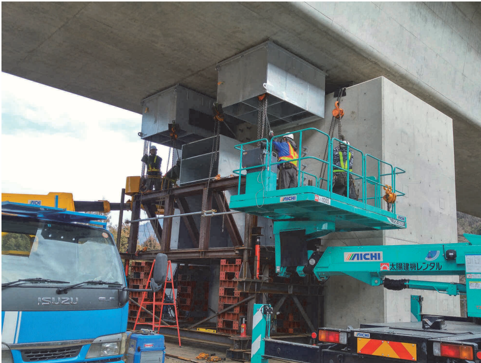
写真-3 木津高架橋 水平力分担構造設置状況
