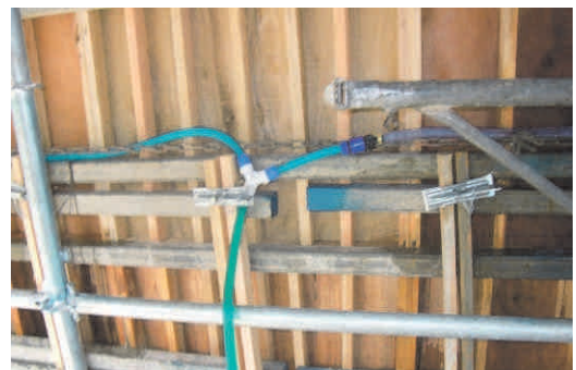
写真-11 自動散水によるコンクリート養生
