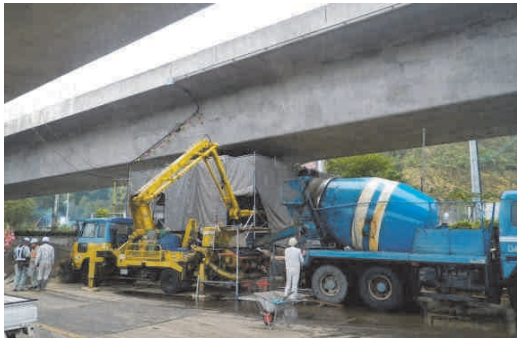
写真-7 コンクリート打設状況 Photo 7 Concrete casting
