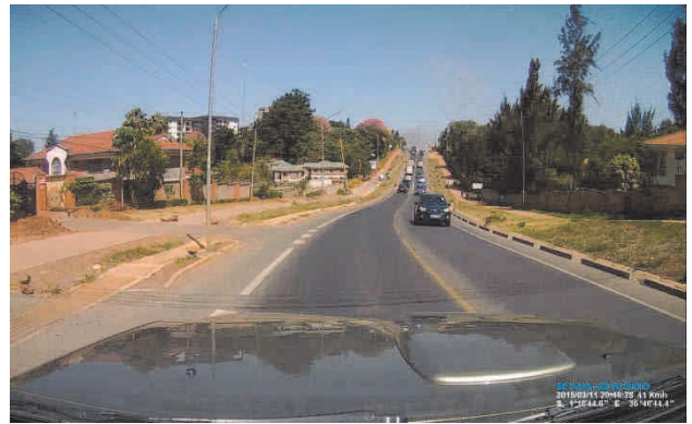
写真-4 ナイロビ市西部環状道路 Photo 4 Nairobi western ring road
