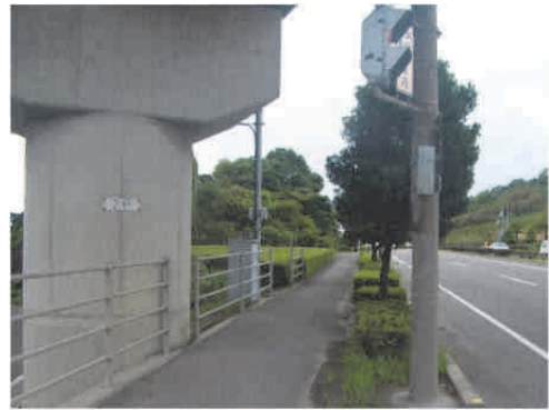
写真-1 国道と市道間に位置する橋脚
