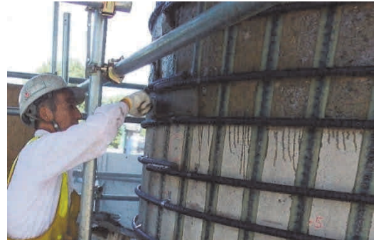
写真-10 モルタル施工状況
