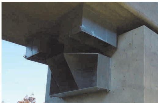
写真-13 木津高架橋橋脚部の水平力分担構造 Photo 13 Installation of stopper(Kizu Viaduct)
