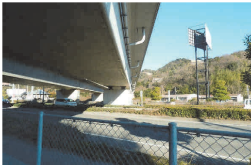
写真-2 木津高架橋と交差国道
