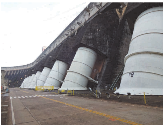
写真-4 イタイダム (発電用導水管Φ10.5m)
