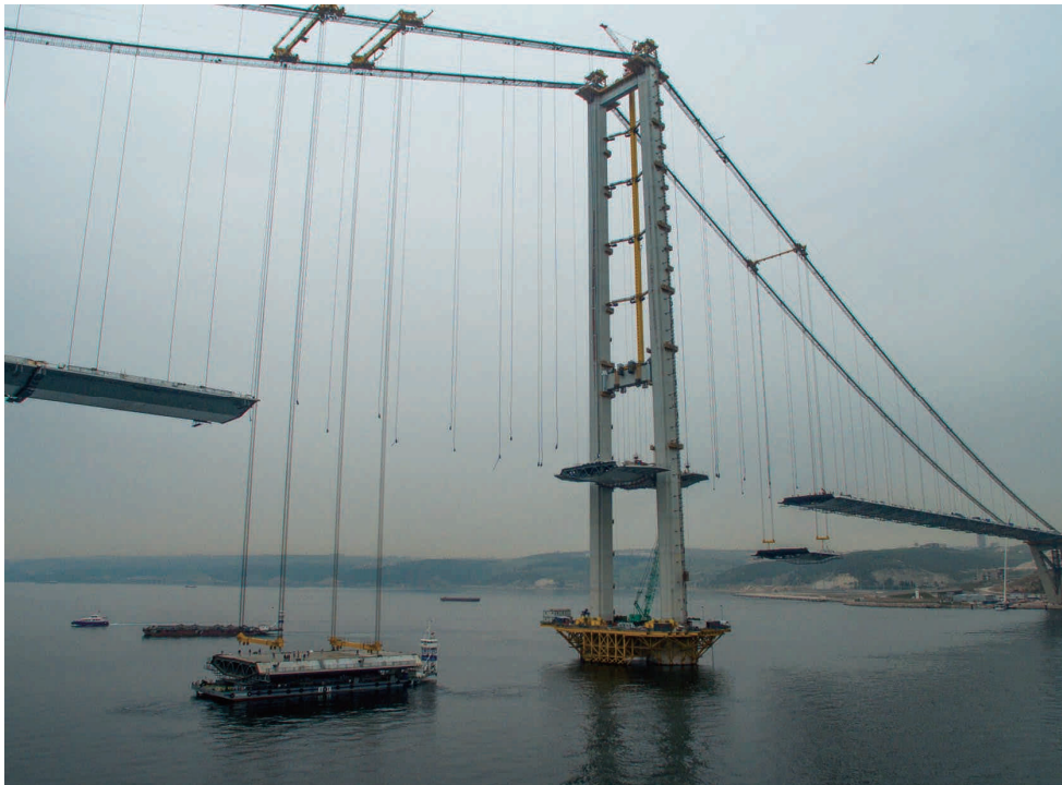
写真-8 直下吊架設
