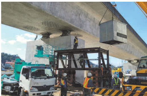
写真-14 横引き台車による水平力分担構造取付 Photo 14 Installation of a stopper by the movable dolly
