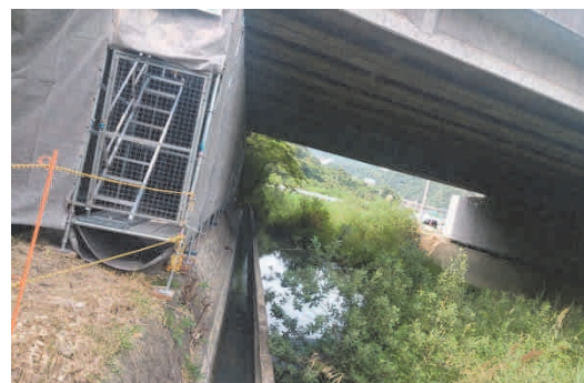
写真-4 中山谷川橋と足場設置状況
