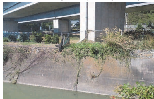
写真-5 木津高架橋と隣接河川
