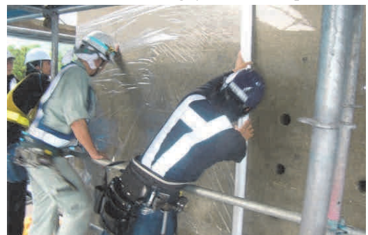
写真-12 大型ラミネートによるコンクリート養生
