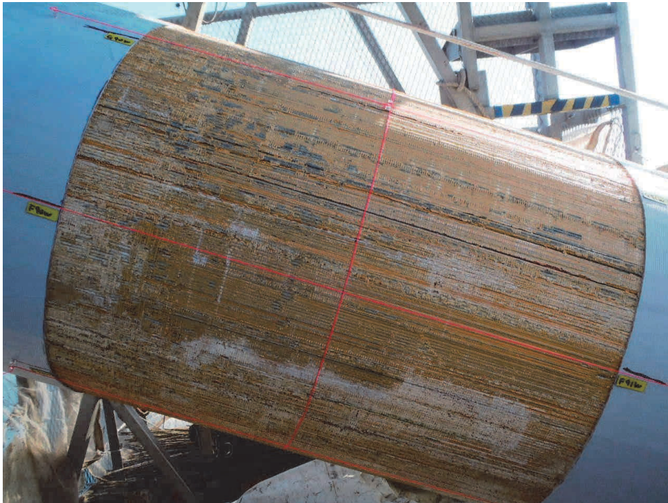
写真-5 下津井瀬戸大橋主ケーブル劣化調査（ペースト表面）
