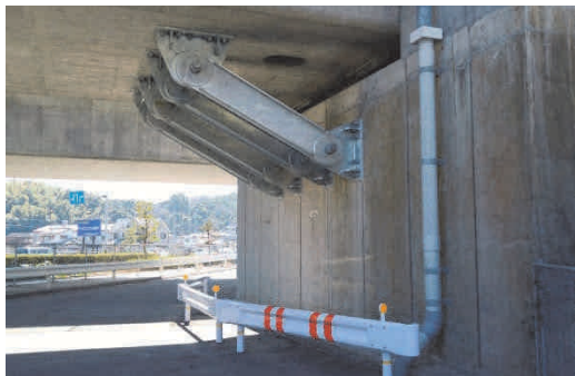
写真-3 水平力分担構造と交差市道
