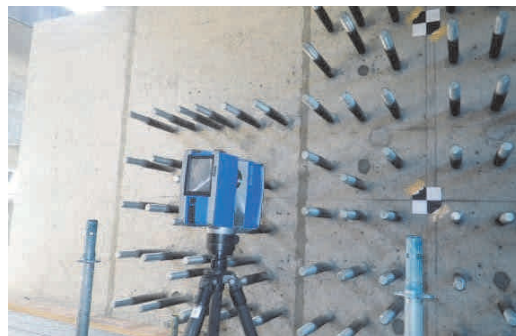
写真-16 アンカーボルトの3D測量 Photo 16 3D laser scanning for anchor bolts
