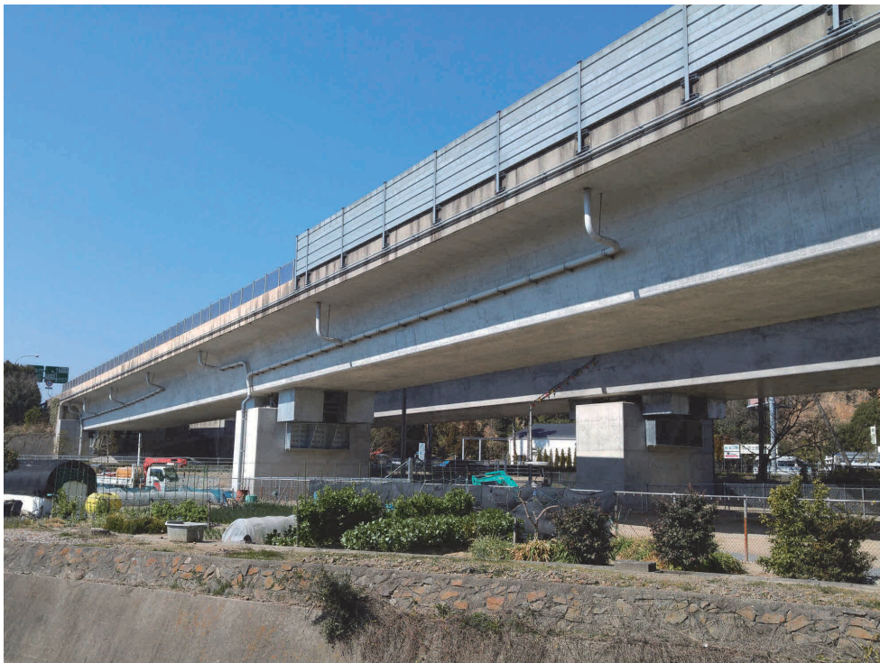
写真-4 木津高架橋 耐震補強完成状況
