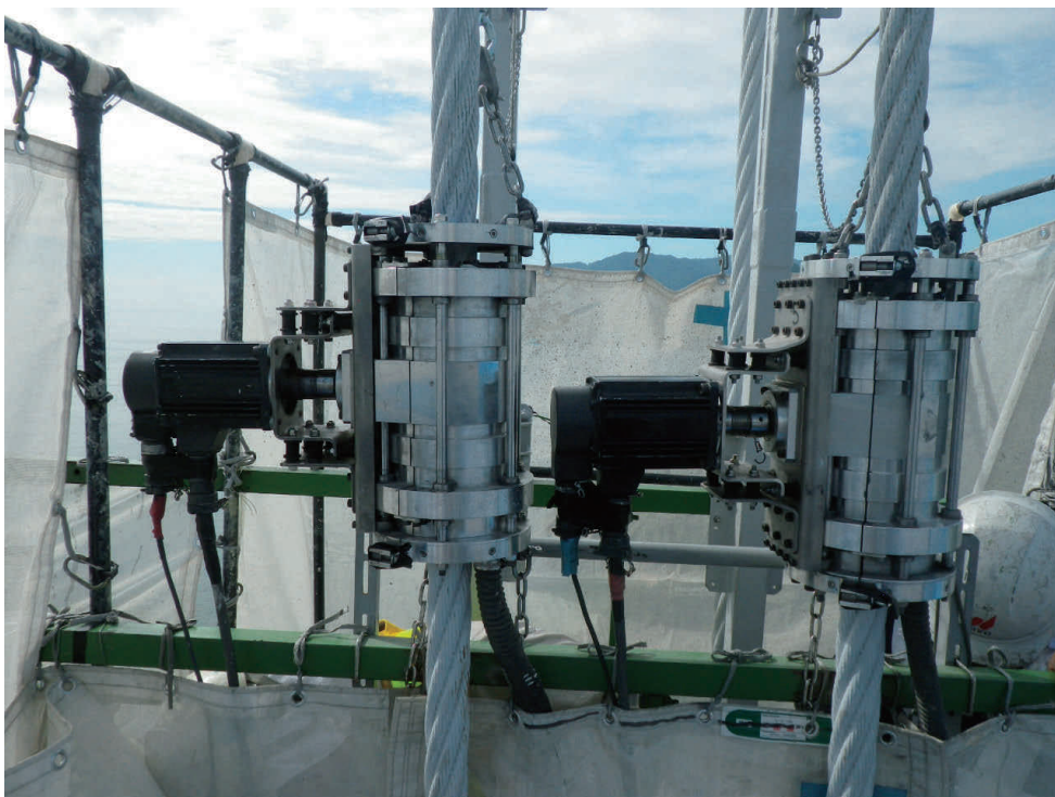
写真-5 因島大橋用ケレン装置
