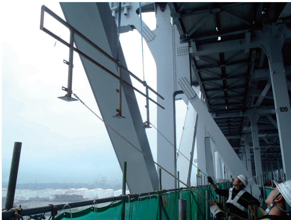
写真－4 管理路手摺現地撤去状況
