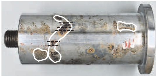
写真-10 調査位置（腐食深さ、成分分析）
