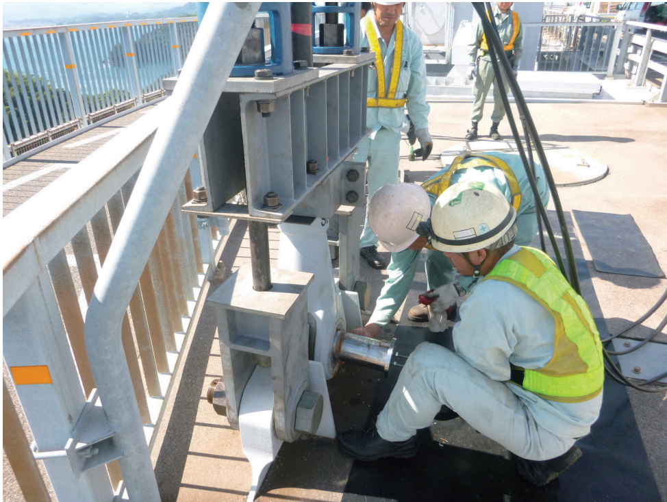
写真-7 ハンガーピン抜き取り状況
