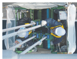
写真-8 塗替え塗装施工状況
