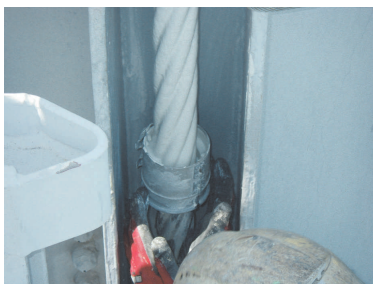
写真-5 簡易浸せき器による塗装
