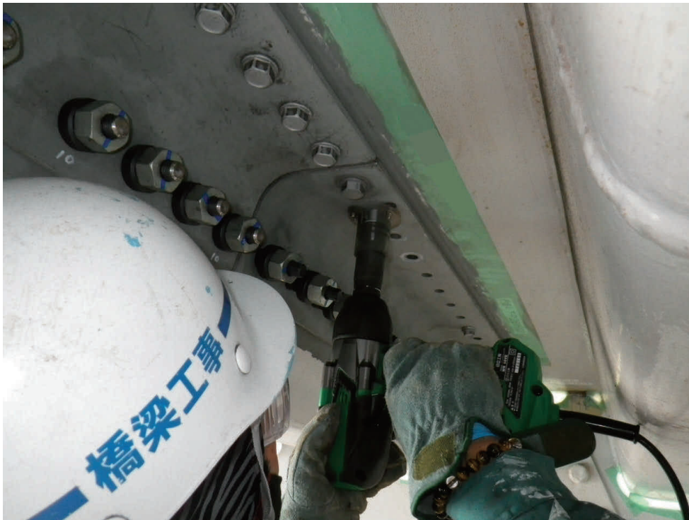
写真－2 実橋試験施工状況
