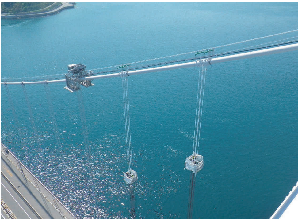
写真-6 大島大橋 ゴンドラによる塗装状況
