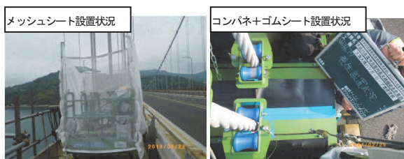
写真-4 ゴンドラ養生 Photo 4 Scaffolding net for gondola
