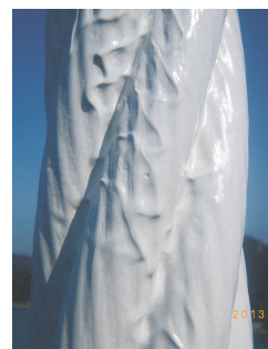
写真-11 中塗り塗装後のシワ Photo 11 Runs of base coat
