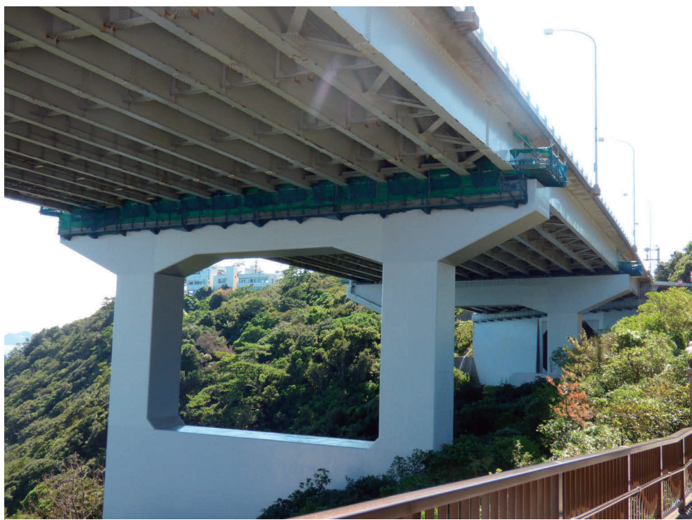
写真-1 支承補修箇所全景
