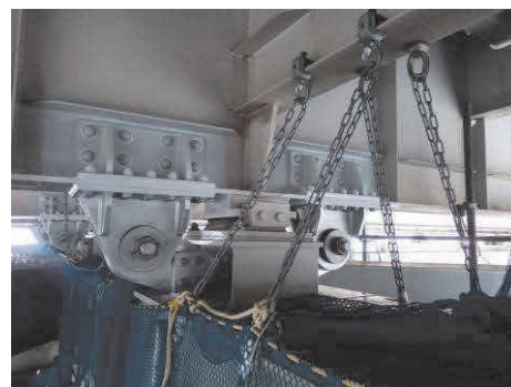
写真-5 道路桁支承補強（与島橋） Photo 5 Seismic Retrofit for Road Deck Bearing
