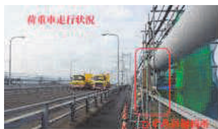
写真-11 実橋計測状況 Photo 11 Actual measurement
