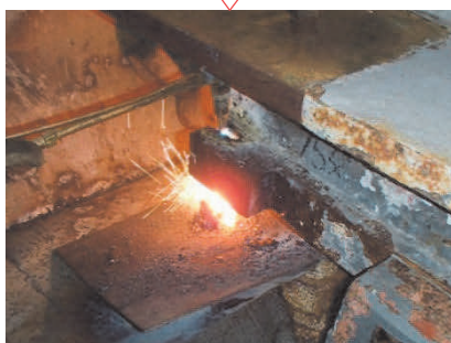
上沓ストッパー切断状況
