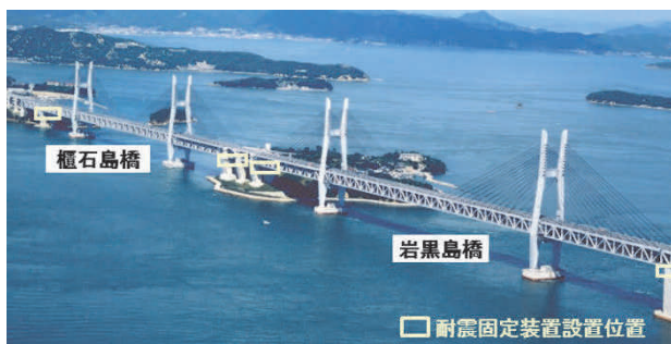
写真-1 耐震固定装置(スプリング沓含む)位置
