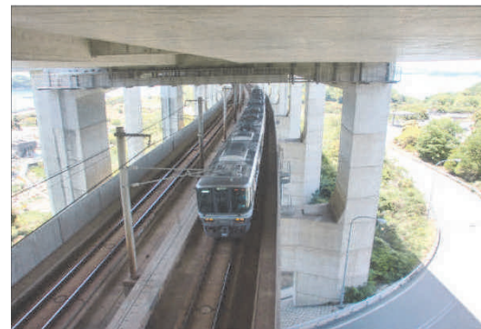
写真－1 鉄道供用中の櫃石島高架橋
