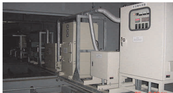
写真-2 ケーブル送気乾燥システム 機器
