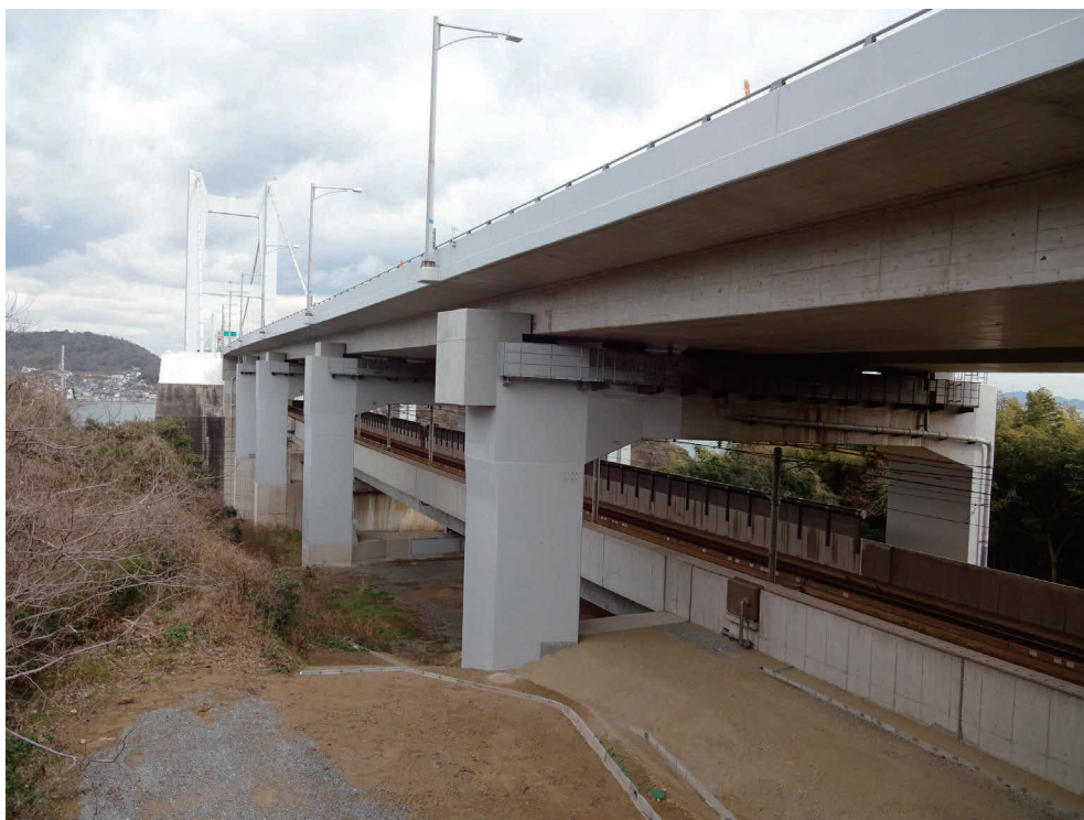
写真－4 櫃石島高架橋の耐震補強
