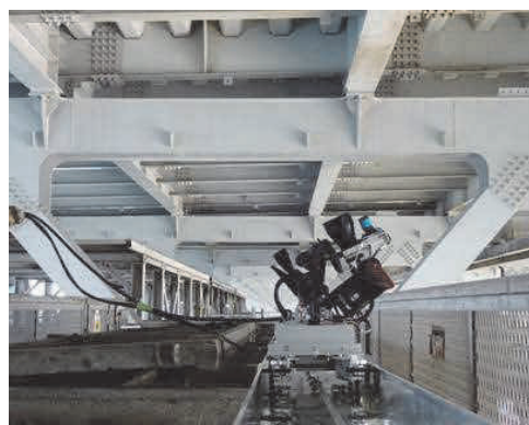
写真-4 開発した撮影装置による点検 Photo 4 Inspection with developed device
