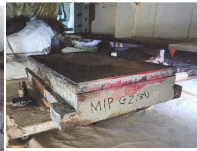
上沓・ソールプレート引き抜き後の状況
