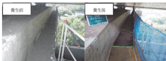
写真-5 管理用通路養生 Photo 5 Protection around maintenance way
