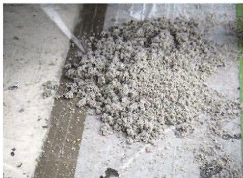
写真－6 グラインダーの素地調整による削りカス Photo 6 Residues after surface preparation by grinder
