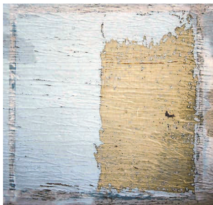
写真－7 高圧洗浄による素地調整 （左：ケース 8、右：ケース 9） Photo 7 Surface preparation by water jet (left: case 8, right: case 9)
