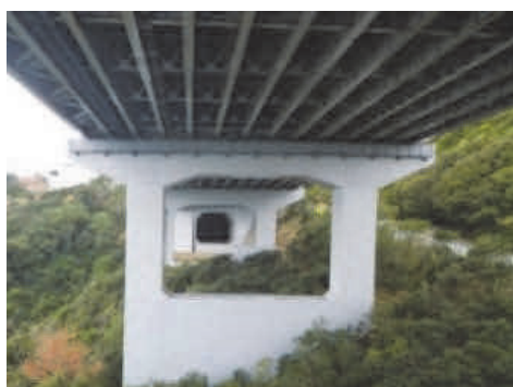
写真-1 孫崎高架橋
