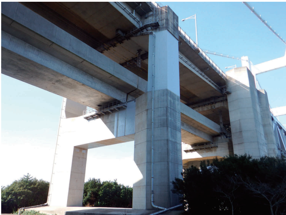
写真－3 下津井瀬戸大橋 PC 桁部の耐震補強
