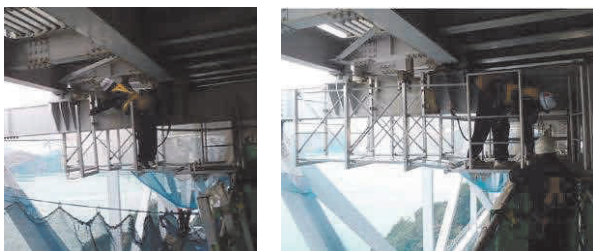
写真-3 ステップ足場の設置状況 Photo 3 Setting-up of step scaffolding
