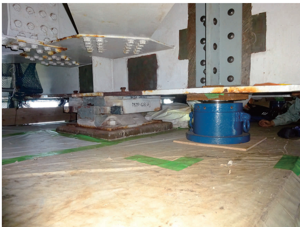
写真-2 ジャッキアップ状況
