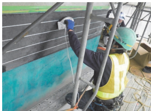
写真－7 アイロンを使用した繊維シート貼付け Photo 7 Fiber lining with iron
