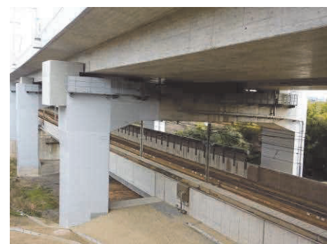
写真-7 繊維巻立て補強（櫃石島高架橋） Photo 7 Fiber Lining
