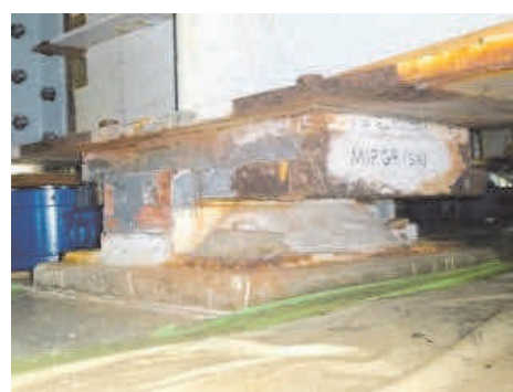
写真-2 補修前の支承
