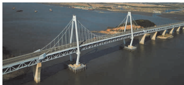
写真-1 永宗大橋
