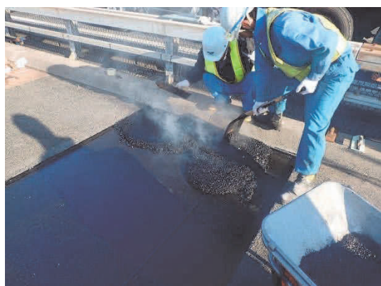
写真-8 グースアスファルトによる部分補修 Photo 8 Partial re-pavement by guss asphalt
