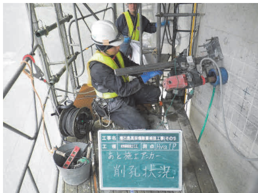
写真－9 コアボーリングマシンによるアンカー削孔 Photo 9 Anchor hole drilling with boring machine
