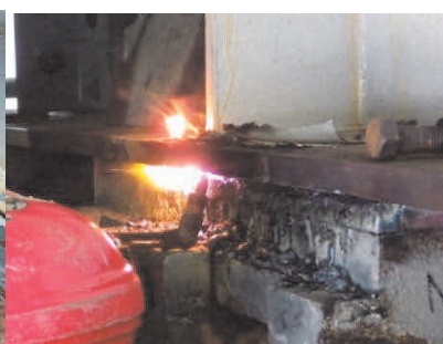
ソールプレート溶接ビード切断状況
