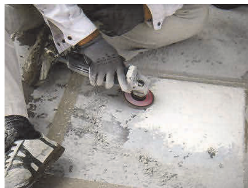
写真-4 グラインダーによる素地調整 Photo 4 Surface preparation by grinder
