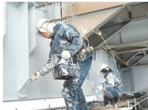
写真-1 省工程塗料試験施工状況
