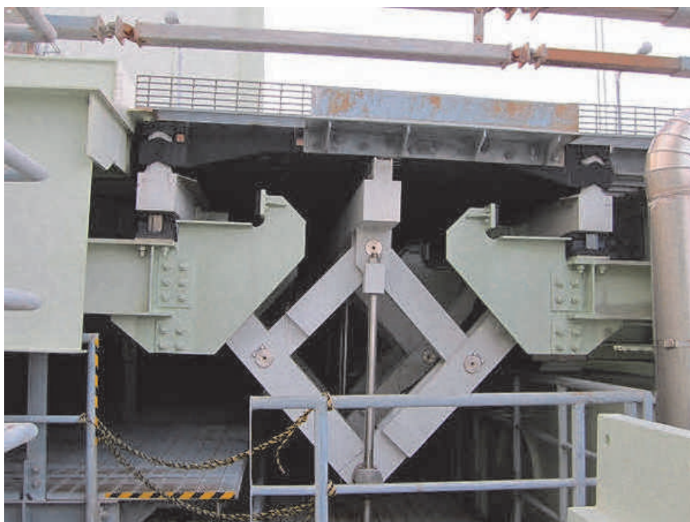
写真-5 明石海峡大橋 リンク式伸縮装置の補強工事
