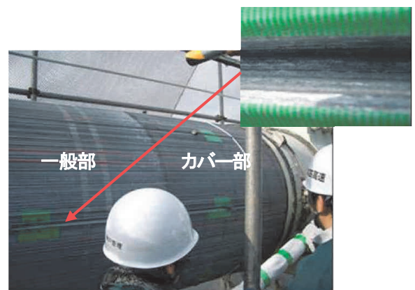
写真-6 明石海峡大橋主ケーブル開放調査(2008年) 13)
