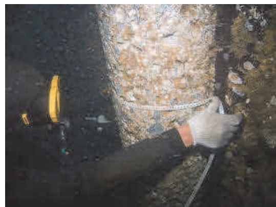
写真-9 陽極消耗量調査 (形状寸法計測)
