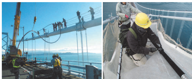
写真-11 大鳴門橋の送気管の取替状況
