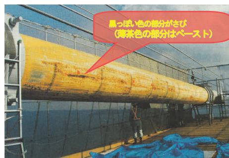
写真-1 因島大橋主ケーブルの開放調査(1989年)
