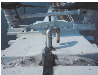
写真-12 既設の排気管 Photo 12 Existing exhaust pipe
