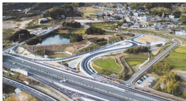
写真-1 上り線側 全景
