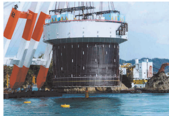
写真-6 防食済みの鋼製ケーソン（来島海峡大橋） Photo 6 Setting of steel caisson (Kurushima-Kaikyo Bridge)
