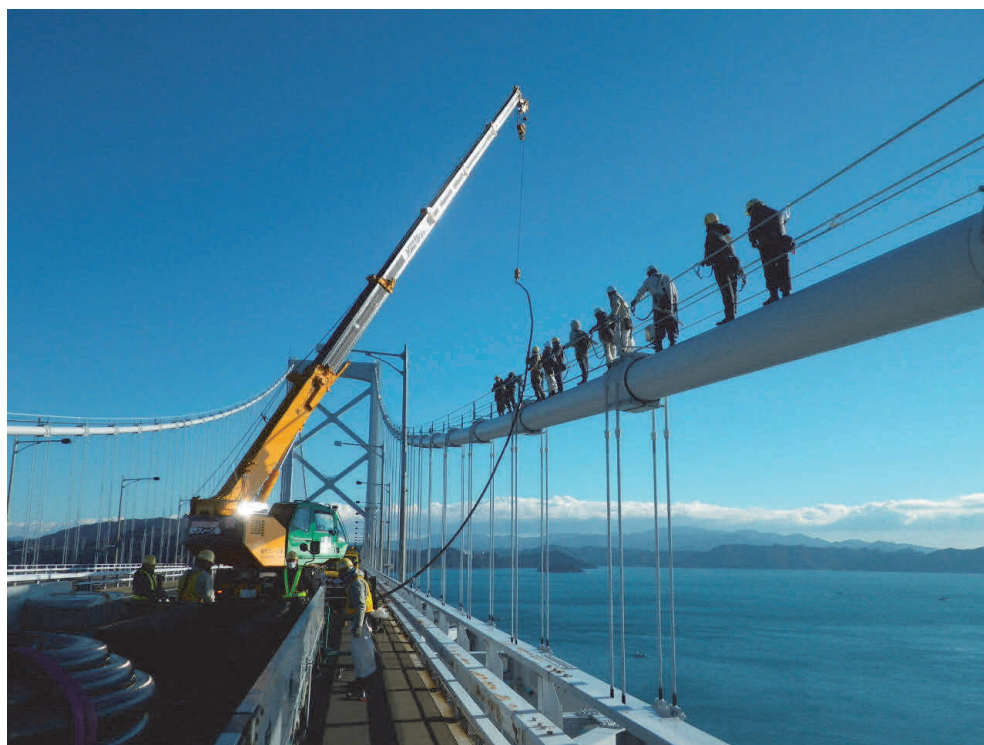
写真-6 大鳴門橋の送気管の取替状況
