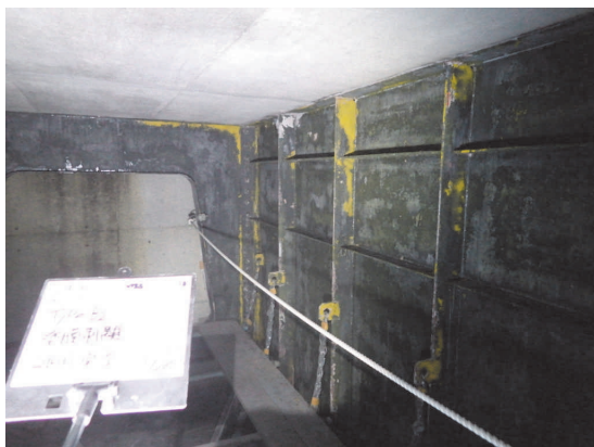
写真-5 剥離剤による塗膜剥離 (2回目)
