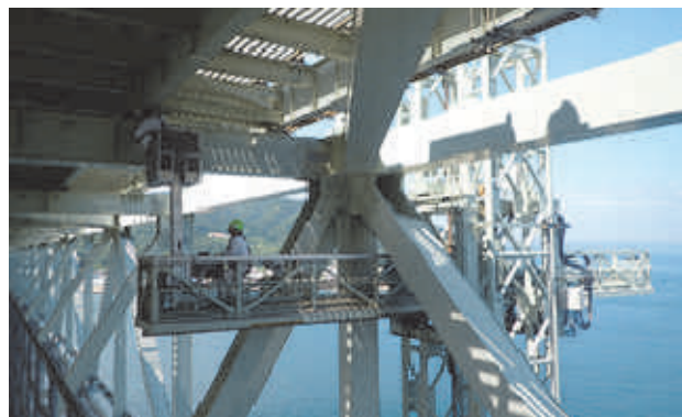
写真-1 桁外面作業車の付加足場
