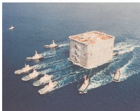
写真-1 えい航中の鋼製ケーソン（瀬戸大橋） Photo 1 Towing of steel caisson (Seto-Ohashi Bridges)
