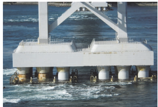
写真-3 多柱基礎外観（大鳴門橋） Photo 3 Multi-column foundation (Ohnaruto Bridge)
