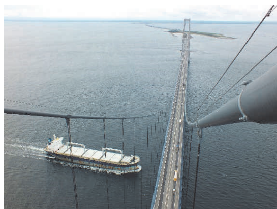
写真-4 グレートベルト・リンク（東橋塔頂より）
