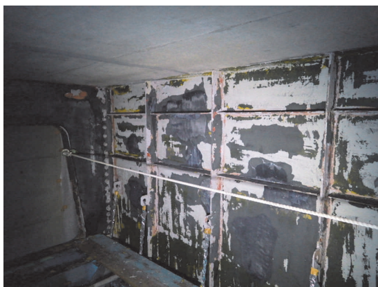
写真-4 剥離剤による塗膜剥離 (初回)
