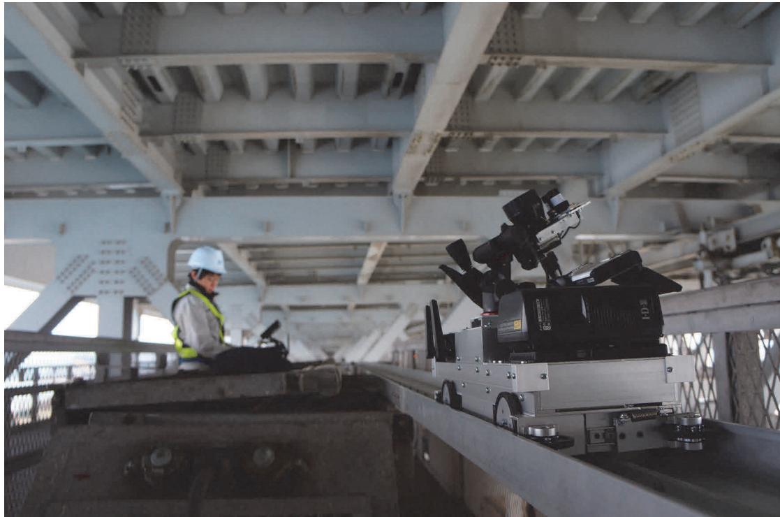
写真-4 亀裂検出システムによる点検状況
