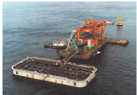
写真-2 海中コンクリート打設（骨材投入 瀬戸大橋） Photo 2 Casting aggregates of underwater concrete (Seto-Ohashi Bridges)
