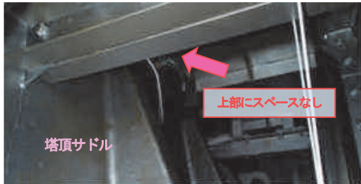
写真-16 大鳴門橋サドル内部の状況
