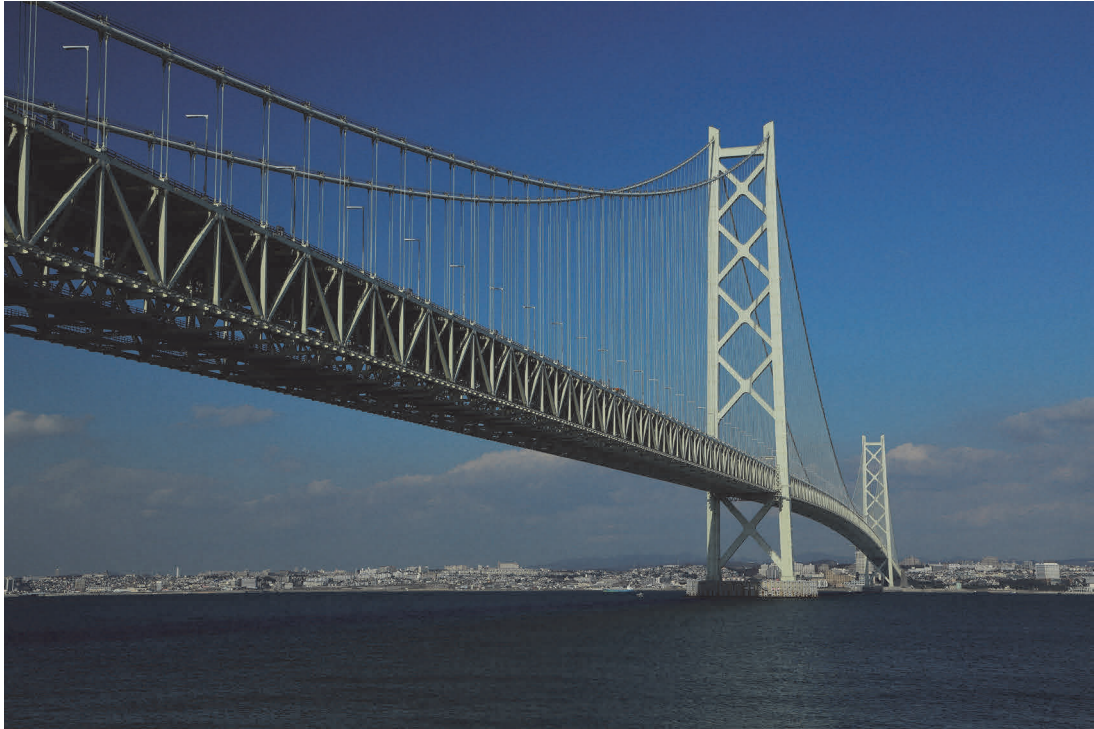
写真-1 淡路島側から望む明石海峡大橋
