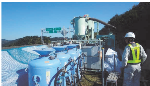
写真-15 プラスト設備設置状況
