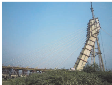
写真-2 Signature Bridge（建設状況）
