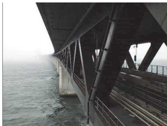
写真-3 オーレスン橋（左奥に斜張橋部）
