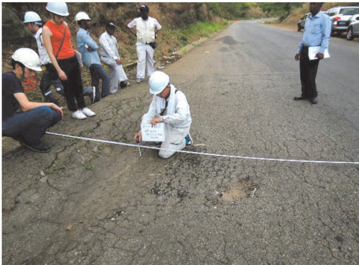
写真-5 路面の隆起、流動した状況 Photo 5 Situation of road rise and flow
