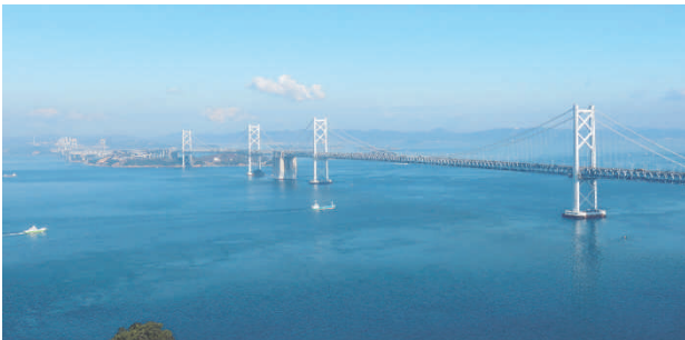
写真-1 瀬戸大橋（番の州側から岡山側を望む）
