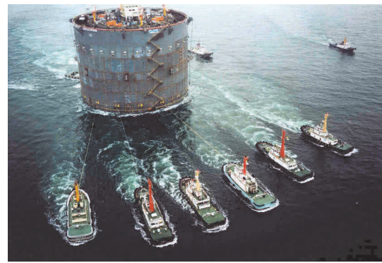
写真-5 えい曳航中の鋼製ケーソン（明石海峡大橋） Photo 5 Towing of steel caisson (Akashi-Kaikyo Bridge)
