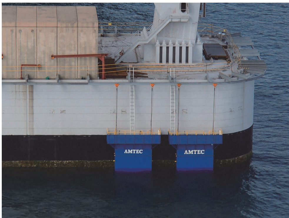
写真-7 ドライボックスによる防食工施工（岩黒島橋 3P）
