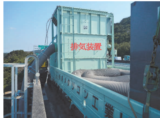
写真-6 排気装置搭載車 (道路上)
