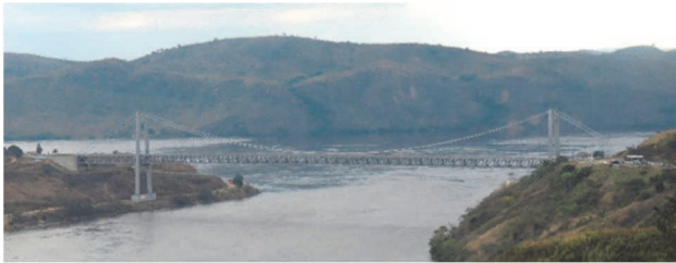
写真-1 マタディ橋全景（上流より） Photo 1 Matadi Bridge (From upstream)
