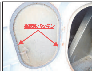
写真-18 マンホールの対策
