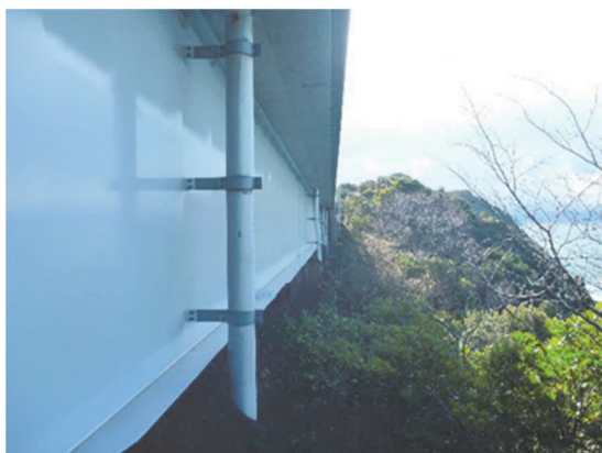
写真-1 第六伊弉高架橋 Photo 1 6 th Ibi viaduct
