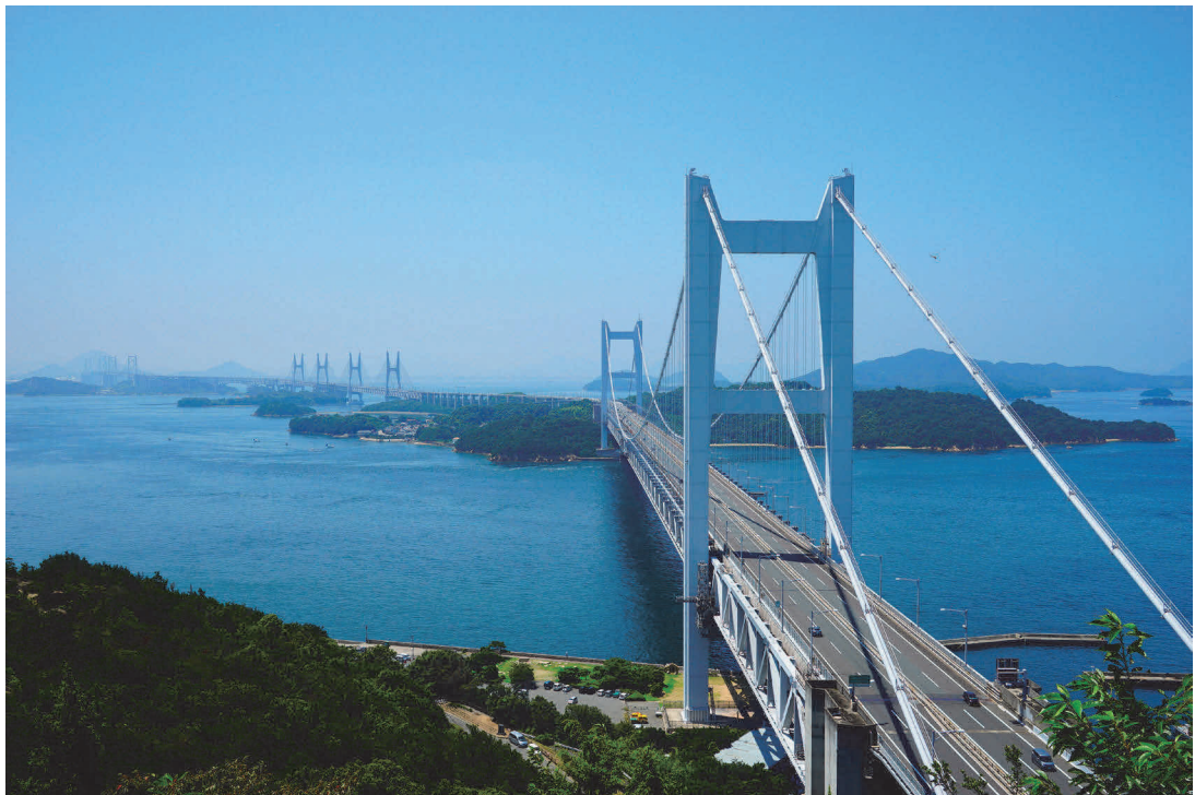
写真-2 岡山県側から望む瀬戸大橋
