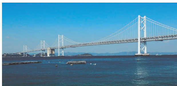
写真-1 北備讃瀬戸大橋(左)と南備讃瀬戸大橋(右)
