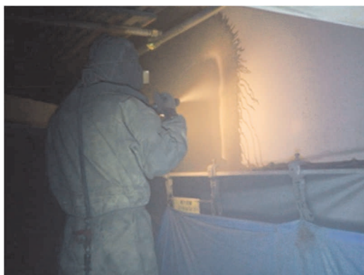
写真-13 湿粒ブラスト状況 Photo 13 Wet blasting work
