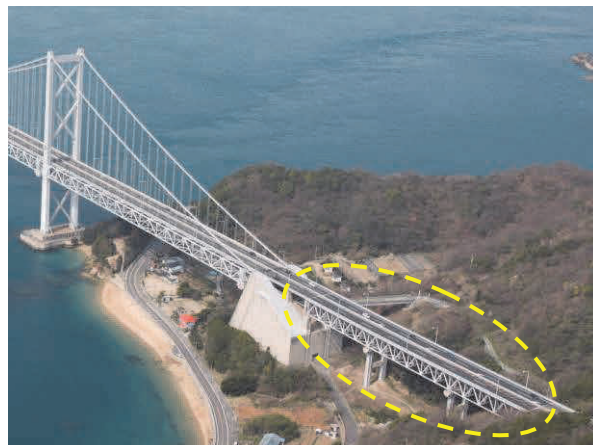
写真－1 因島大橋東高架橋 Photo 1 Innoshima Higashi Viaduct
