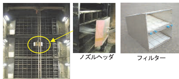
写真-11 ウォータージェット式除じん再生装置
