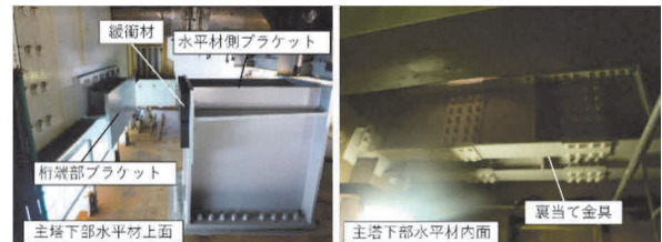
写真-1 衝突対策構造設置状況
