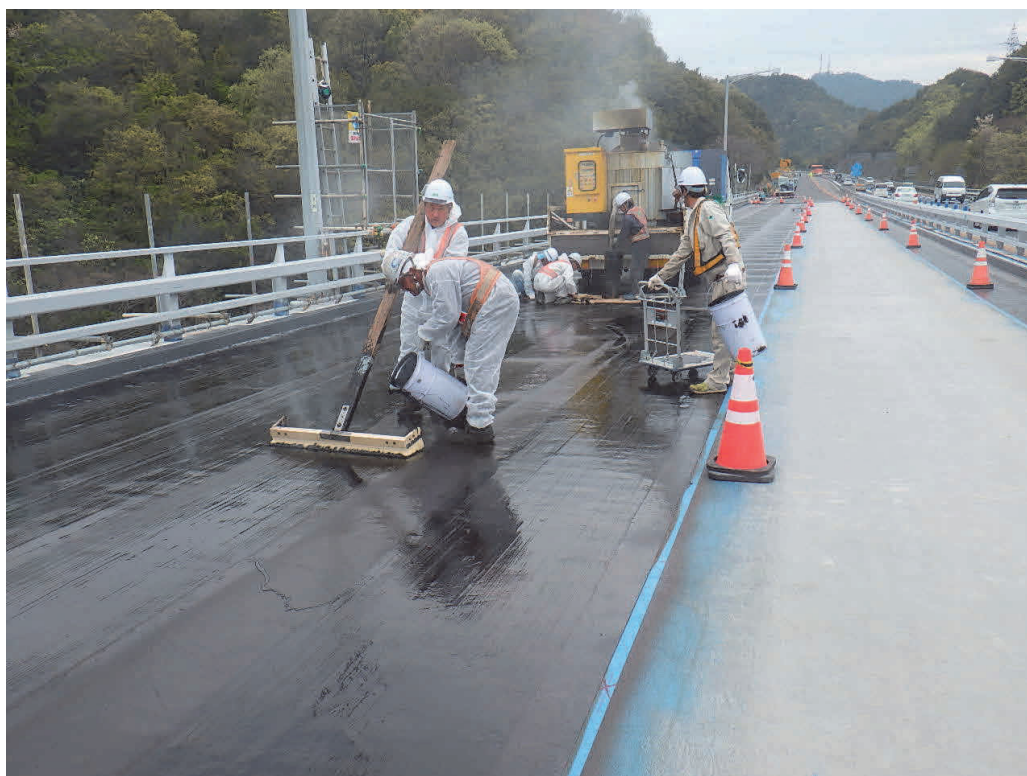
写真－6 床版防水工施工
