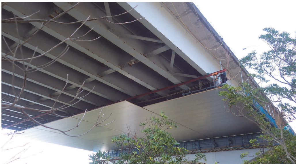
写真－3 裏面パネルの設置状況
