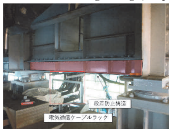
写真-4 段差防止構造設置状況
