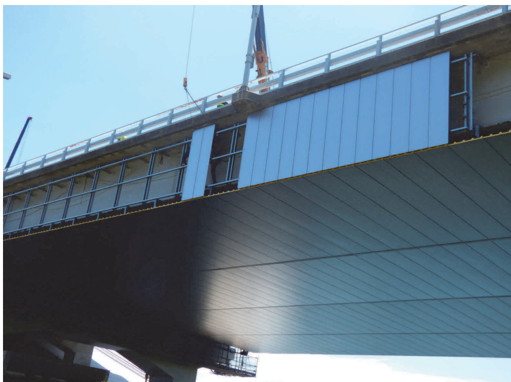
写真－4 側面パネルの設置状況
