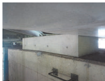
写真-3 支承補完構造 (RC台座方式)
