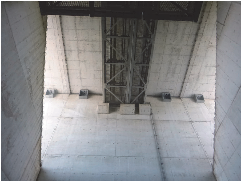
写真－2 支承補完構造（4A 上屋）
