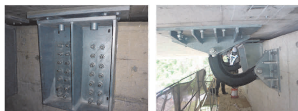
(a) 支承補完構造 (b) 落橋防止構造 写真-5 アンカレイジ上屋補強部材設置状況
