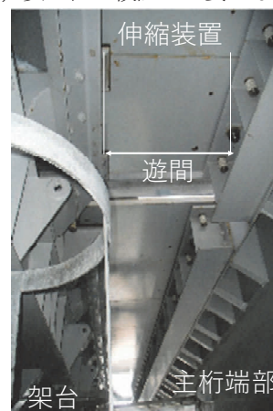
写真-2 来島海峡大橋 8P 中央径間側伸縮装置 Photo 2 Expansion Joint at 8P, Kurushima-Kaikyo Bridge
