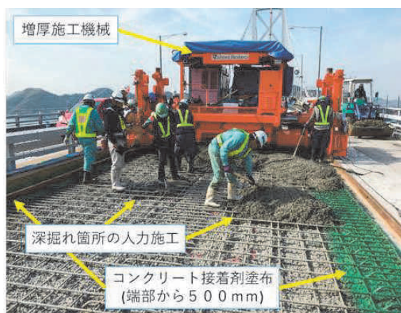
写真-13 超速硬 SFRC の打設状況
