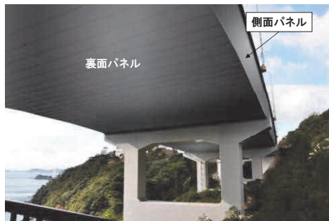
図-4 擬似箱桁化完成イメージ
