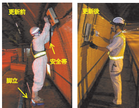
写真-1 火災検知器の清掃状況
