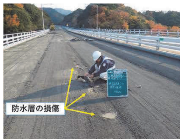
写真－8 既設床版防水層の状況 Photo 8 Existing waterproofing layer
