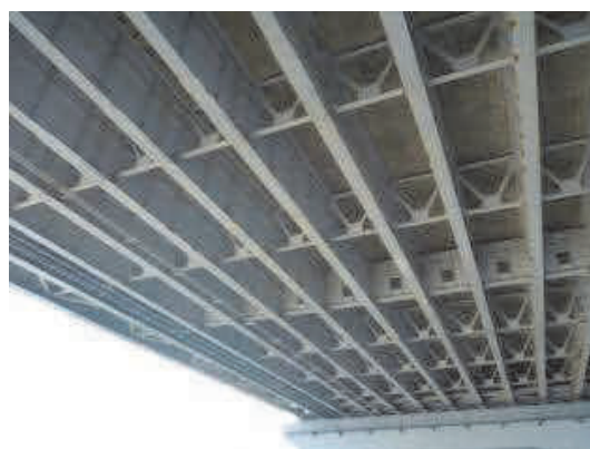
写真-2 多主桁構造
