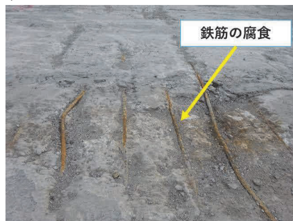
写真－9 既設床版コンクリートの状況 Photo 9 Existing concrete slab
