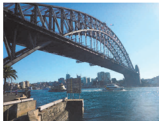
写真-4 シドニー・ハーバー・ブリッジ
