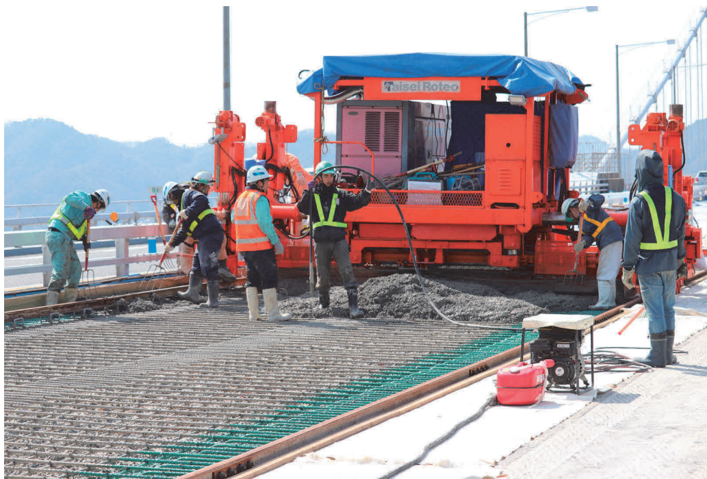
写真－5 超速硬 SFRC コンクリート打設
