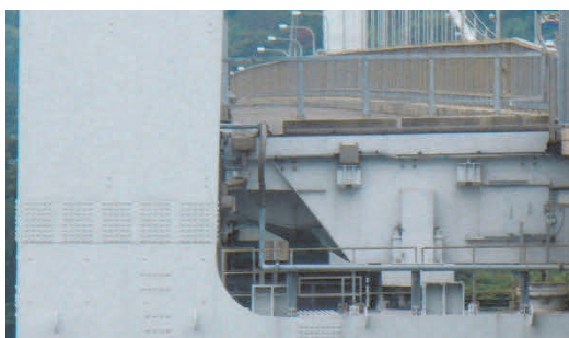
図-7 主塔と補剛桁の衝突部
