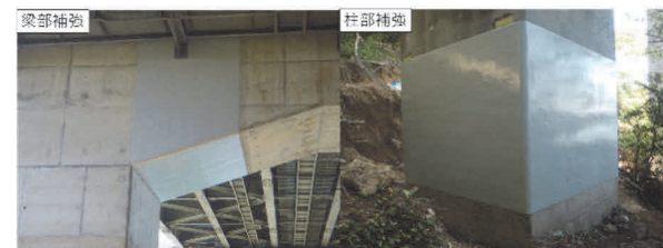
写真-2 炭素繊維シート補強
