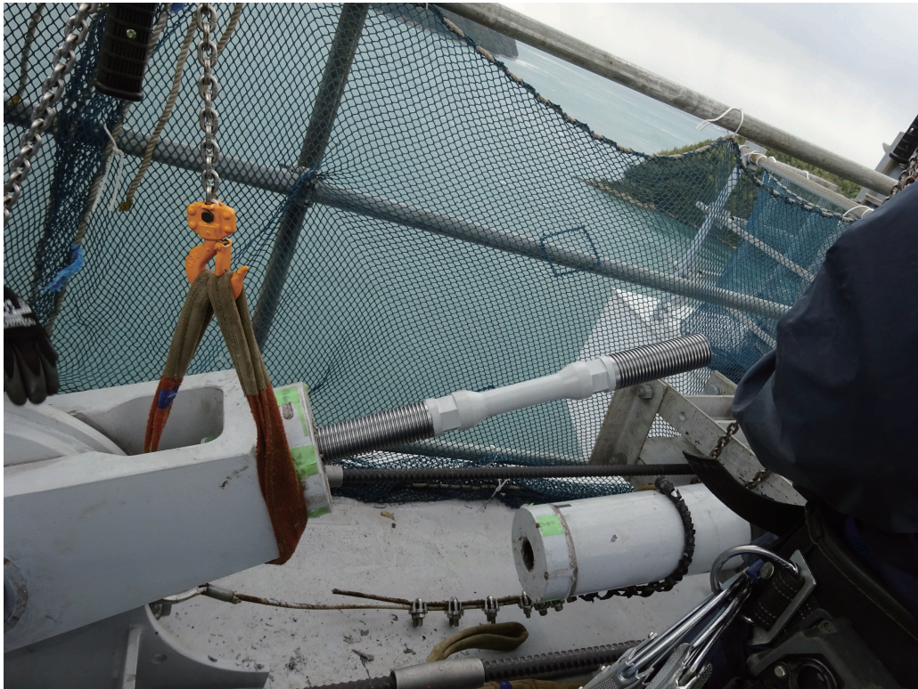
写真-1 センターステイロッド交換状況
