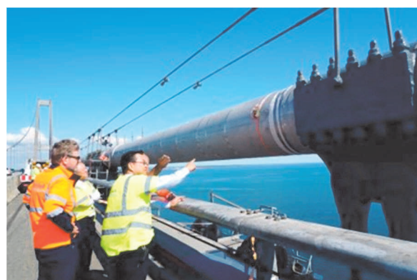
写真-2 メインケーブル耐火対策
