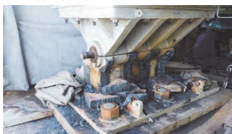
写真－9 支承解体状況 (HVa30P)
