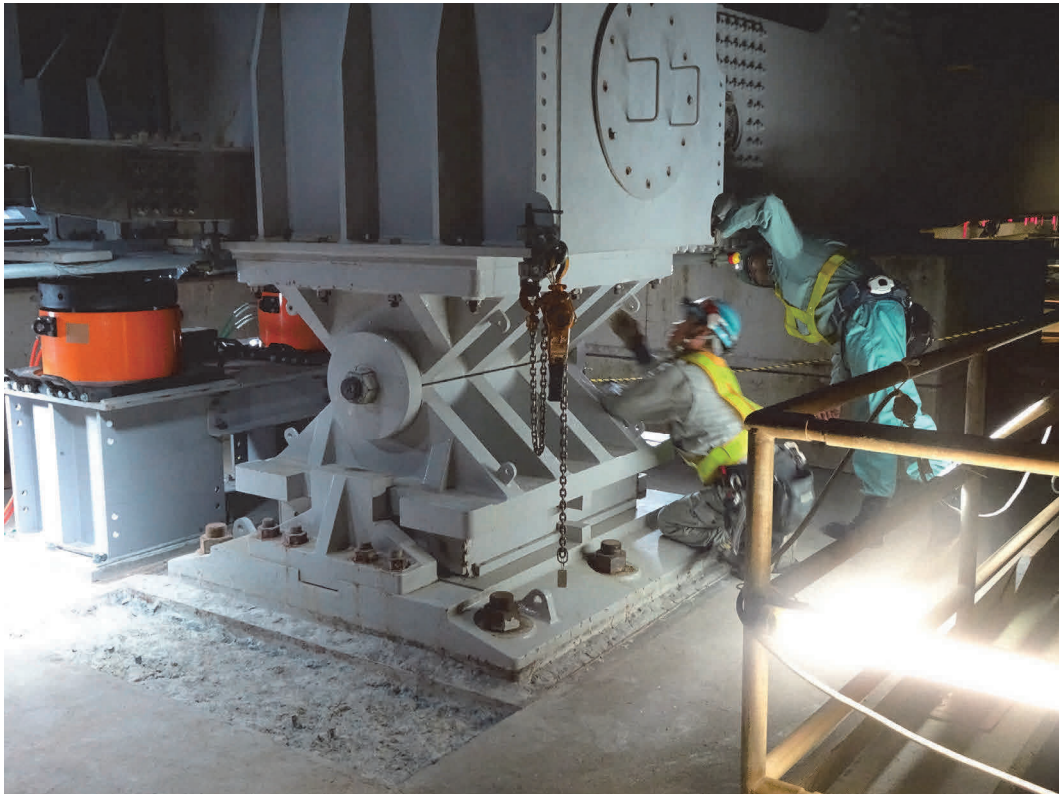
写真－1 トラス桁ジャッキアップ状況（HB1P: 櫃石島高架橋トラス部）
