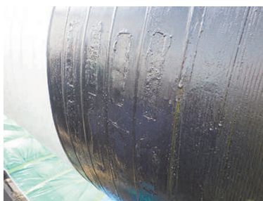
写真－2 ブチルゴム系プライマー（2層目） Photo 2 Butyl rubber adhesive(second layer)
