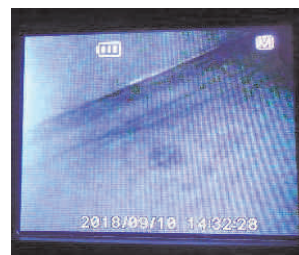
写真-5 内部確認状況
