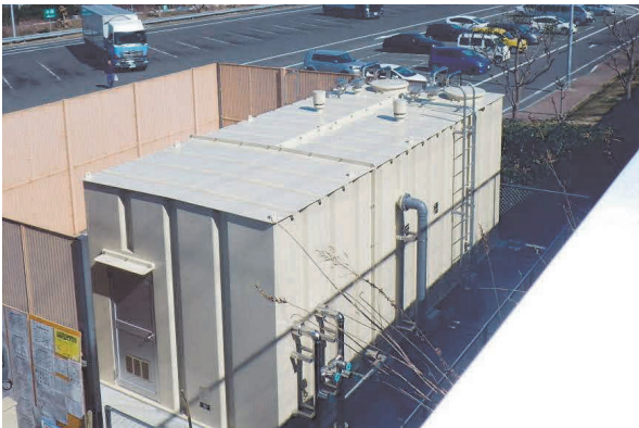
写真-3 受水槽の外観（下り線）
