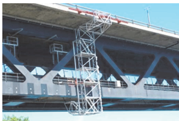
写真-4 塗替塗装用プラットフォーム
