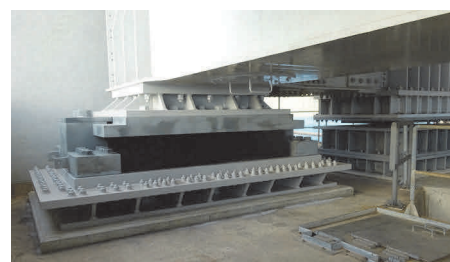
写真－10 新設ゴム支承 (HVa30P)
