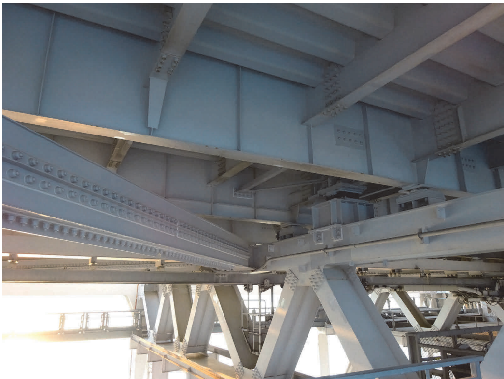
写真－2 機能分散型慣性力分散支承と部材補強工事（与島橋 2 径間部）
