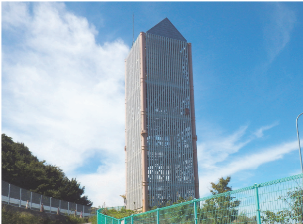
写真-2 上水・再生水用高架水槽の外観
