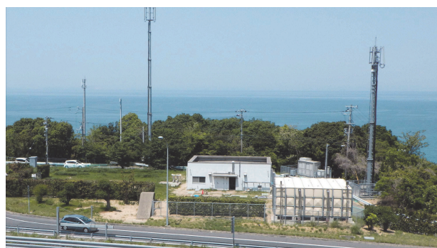
写真－4 汚水処理設備と中水貯留槽（上り線）
