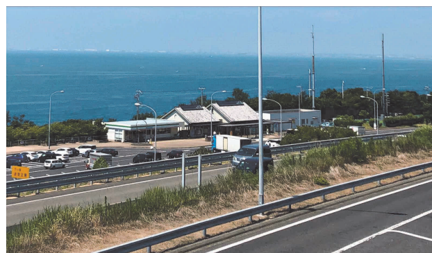
写真-1 室津PA（上り線） Photo 1 Murozu rest area (Up line)
