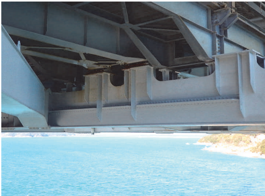
写真-2 櫃石島橋・横トラス下弦材の TRS による T 字形材接合
