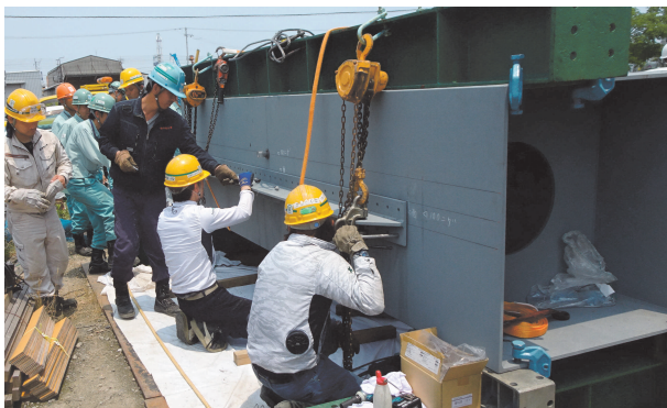
写真-7 施工試験状況
