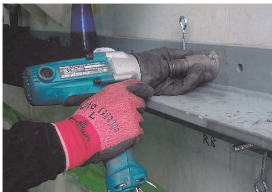
写真-11 TRS 一次締め付け Photo 11 Primary tightening
