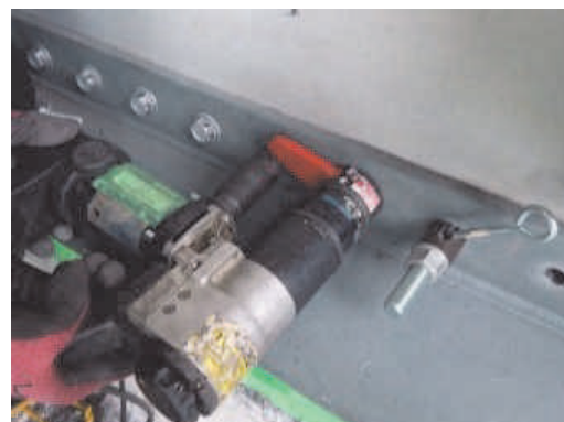
写真-12 TRS 二次締め付け Photo 12 Secondary tightening
