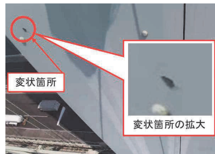
(a) 主塔点検ロボットの撮影画像
