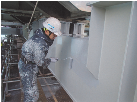
写真-3 H25試験施工 塗装作業
