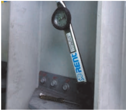
写真-15 トルク計測 Photo 15 Torque measurement
