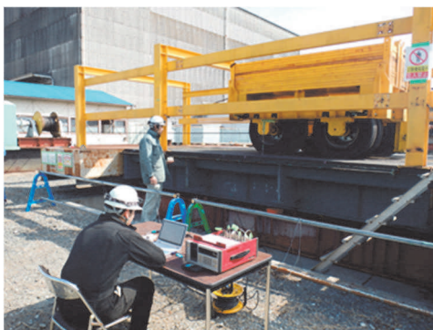
写真-5 たわみ測定状況
