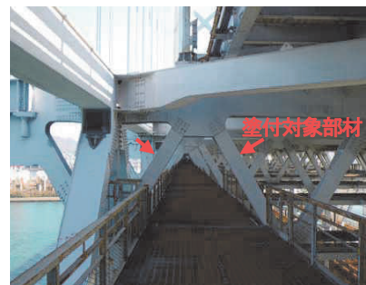
写真-1 H24試験施工
