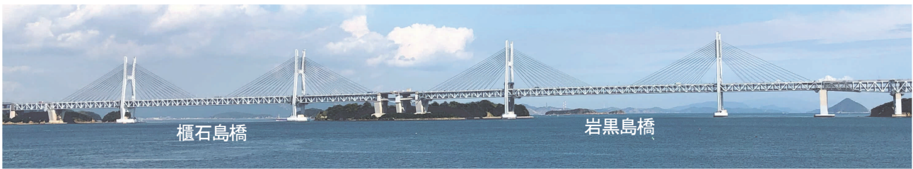
写真-1 櫃石島橋及び岩黒島橋
