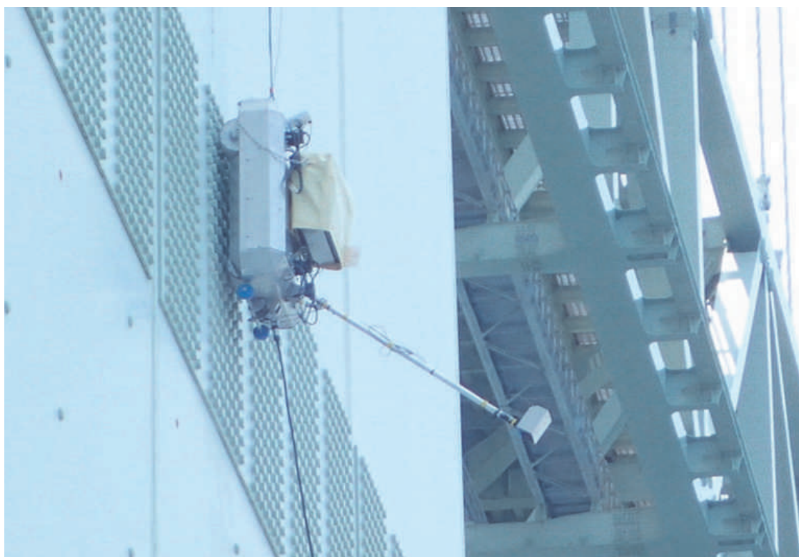
写真-4 主塔点検ロボットによる壁面の点検状況（拡大）
