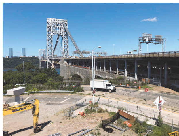
写真-3 ジョージ・ワシントン橋
