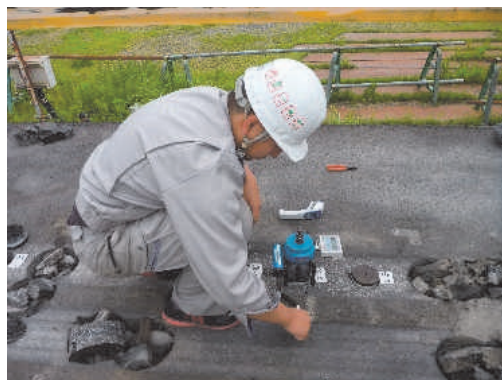
写真-7 引張接着試験状況 Photo 7 Tensile adhesion test status
