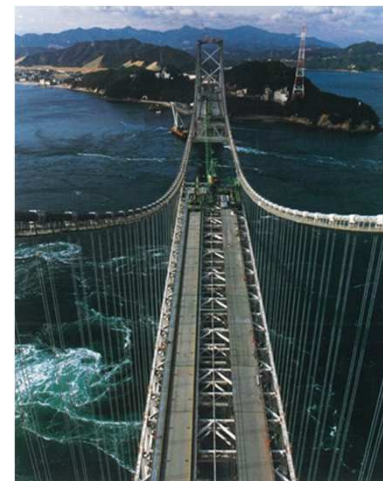
桁架設状況(主塔より)
