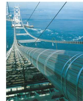
ケーブル架設完了
