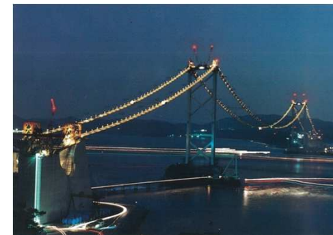
夜間のケーブル調整作業 ケーブルの形状調整は、温度の安定する夜間に実施
