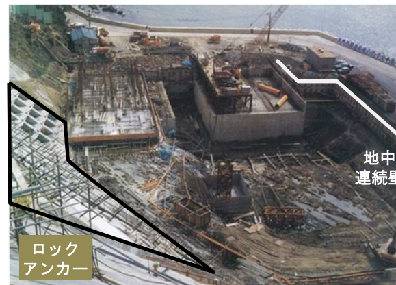
アンカレイジ掘削状況(5A)
