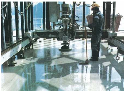
基礎コンクリートの研磨 鉛直精度を確保するための研磨仕上げ
