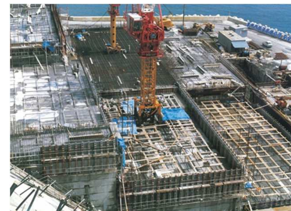
アンカレイジ施工状況(5A)
