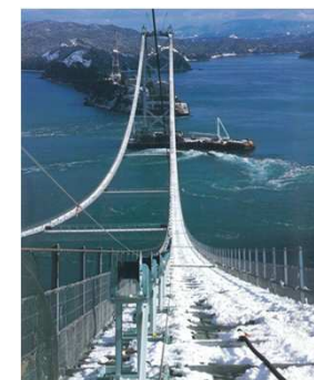
積雪したキャットウォーク 架設の作業足場となるキャットウォーク
