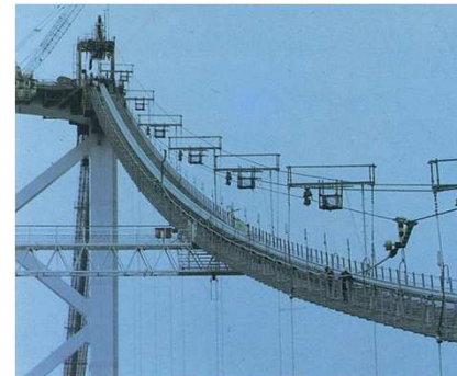
ストランド架設状況 ストランドを1本ずつ引き出して架設
