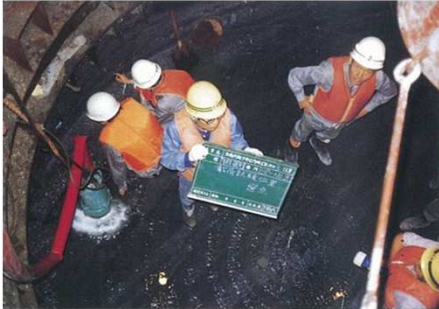
鋼管内の海水を抜いて掘削 海面下20mの支持地盤まで掘削
