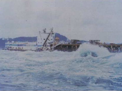
急潮流下での施工(3P) 最大11kt(5m/s以上)の急潮流下で施工 コンクリートプラント船による打設
