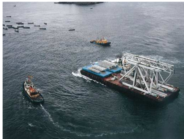
桁部材の海上運搬状況 架設する部材毎に複数ブロックを台船にて海上運搬
