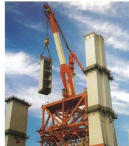
主塔部材の架設状況 90t吊クレーンにより部材を架設
