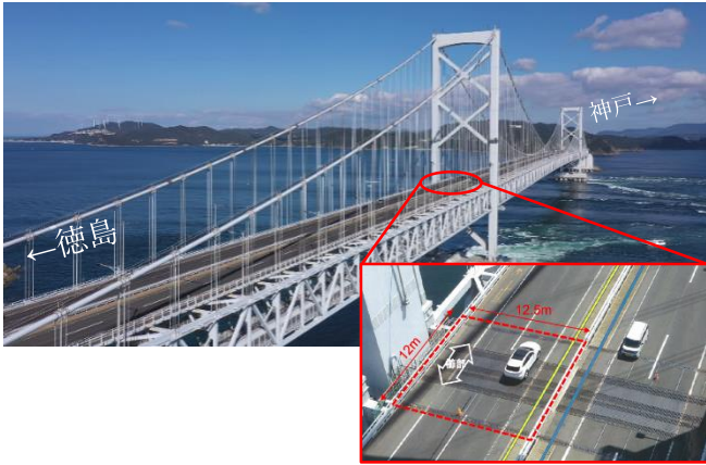
①大型伸縮装置交換箇所
