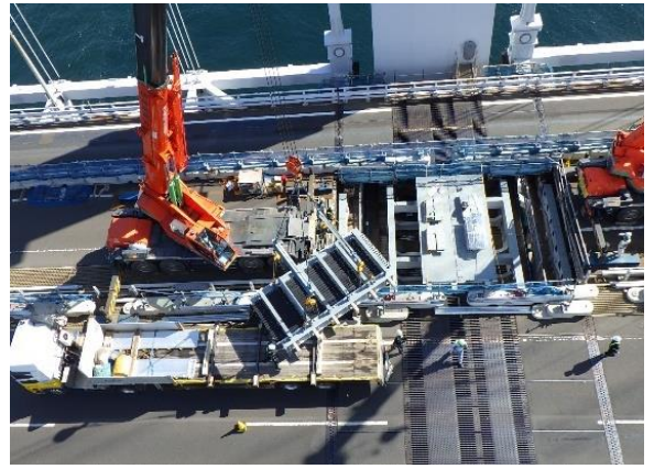
④(新)大型伸縮装置設置作業状況
