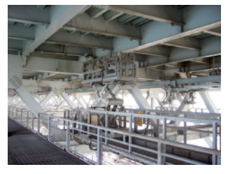
桁内面作業車見学!
