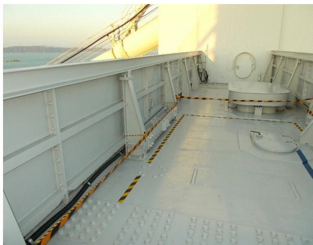
足元に注意が必要な箇所 ボルトが出ている
