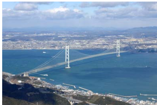
写真-1 明石海峡大橋 (Photo 1: Akashi-Kaikyo Bridge)
