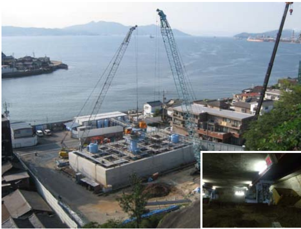
写真-2 警固屋側ケーソン（白枠内:ケーソン内部） (Photo 2: Caisson on Kegoya-side and inside of the caisson)
