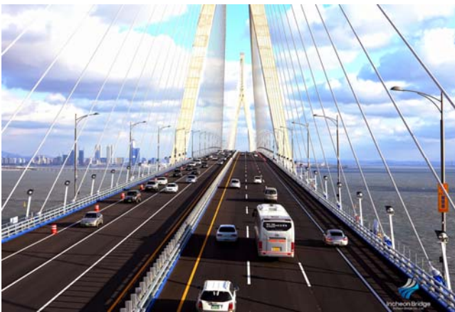
写真-4 仁川大橋 (Photo 4: Incheon Bridge)
