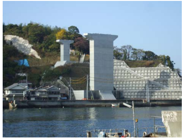
写真-3 音戸側下部工 (Photo 3: Piers on Ondo-side)
