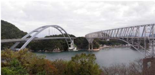
写真-3 新天門橋の完成イメージ。
