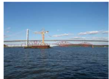
写真-8 第二フォース道路橋 Photo-8 Force Replacement Crossing
