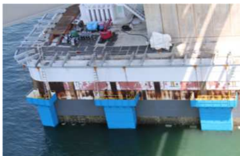
写真-1 施工状況（ドライアップ設備）
